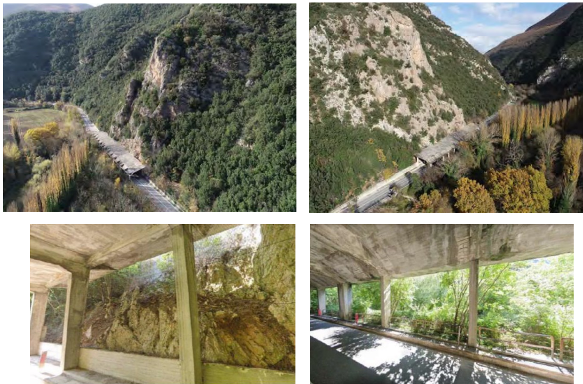
Figura 2: Stato di fatto dell'area di intervento. In alto: l'area interessata. In basso: l'interno della galleria, lato versante (sinistra) e lato valle (destra). Fonte: Lista di controllo e Report fotografico ad essa allegato
