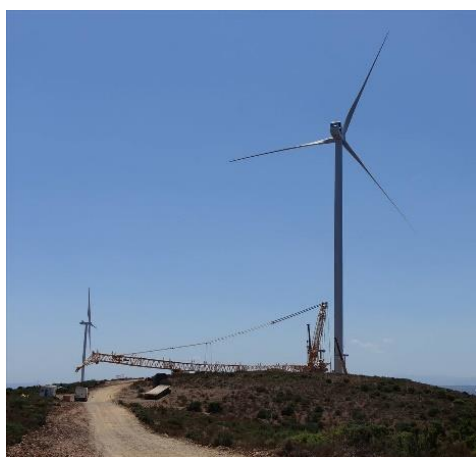
FIG. 30 – SPAZI DI MONTAGGIO PER LA GRU PRINCIPALE
