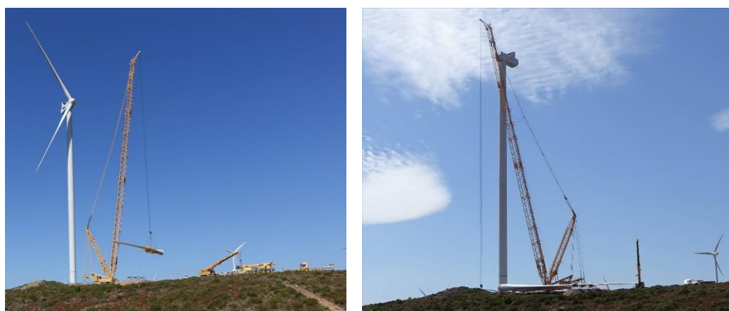
FIG. 33 – OPERAZIONI DI MONTAGGIO CON GRU
