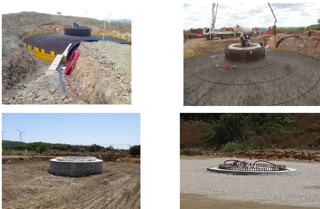
FIG. 27 – FASI REALIZZATIVE FONDAZIONI
