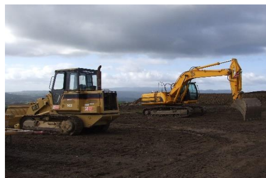
FIG. 31 – OPERAZIONI DI REALIZZAZIONE PIAZZOLE
