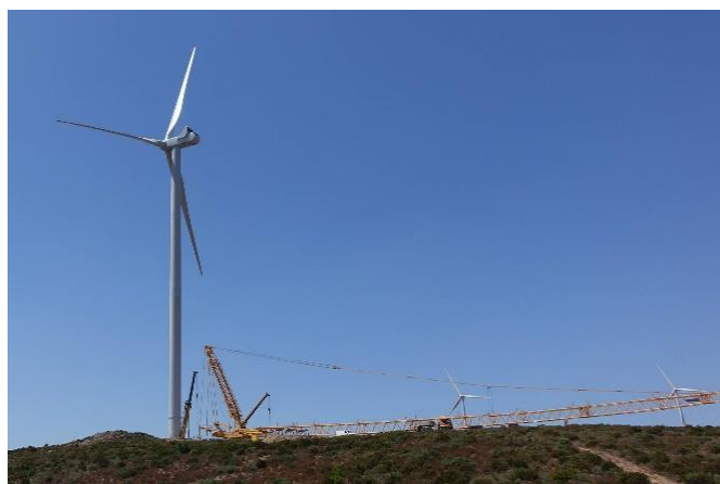
FIG. 30 – SPAZI DI MONTAGGIO PER LA GRU PRINCIPALE
