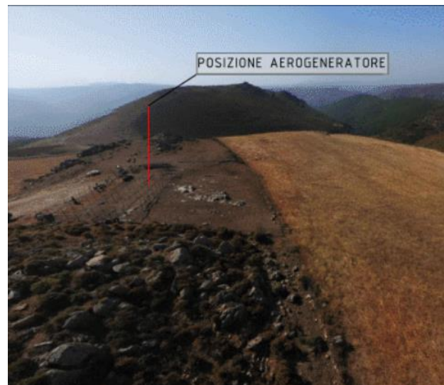
Figura 19. Posizione della piazzola su foto da satellite e vista del punto di Lay-out del previsto aerogeneratore SE_03 (Scala 1:2000; dalle Tavole tecniche: SE_PC_T008.1 - Analisi Piazzole).
