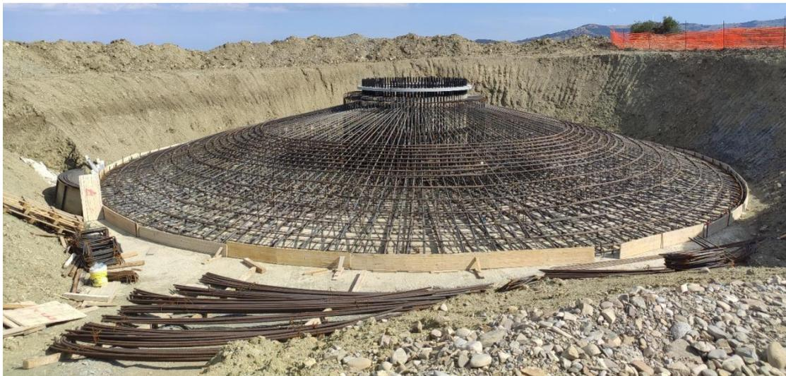
**Figura 4: armatura plinto tipo**
