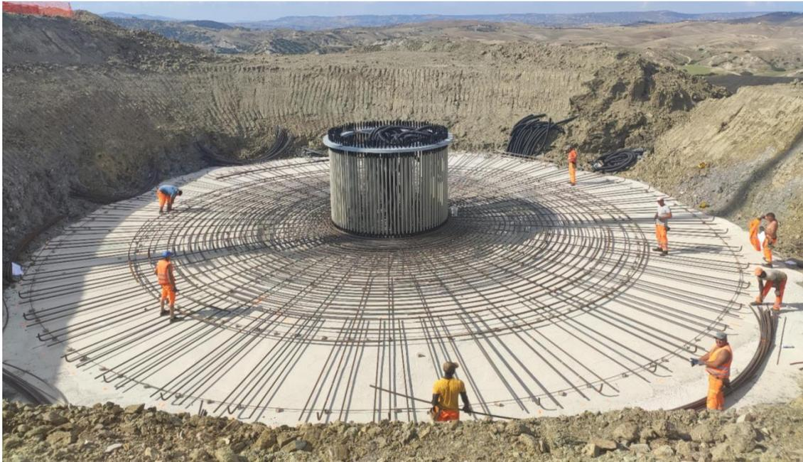
**Figura 5-3: immagine tipo posa anchor cages**
