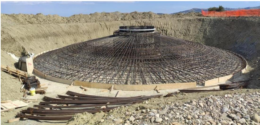
**Figura 5-4: immagine tipo armature plinto**
