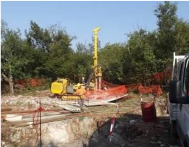
Figura 9.3: Esempio di realizzazione di una fondazione a micropali.
