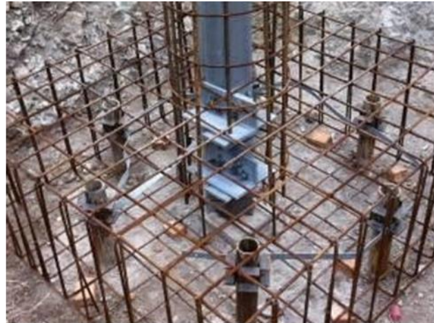
Figura 9.3: Esempio di realizzazione di una fondazione a micropali.
