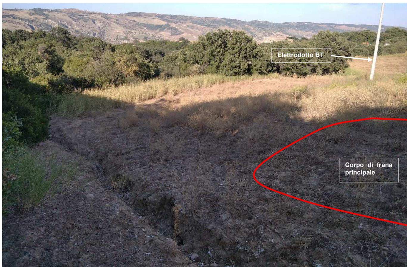
*Foto 4-24. Ripresa da sud verso nord del fosso perimetrale occidentale del campo e del palo dell'elettrodotto di BT che borda a valle il corpo principale della frana. Si osserva anche la mancata regimazione basale nel versante, ove parte delle acque del fosso perimetrale vengono deviate verso nord-est (zona di accumulo di detrito con vegetazione idrofila) in direzione del lago oltre il boschetto.*
