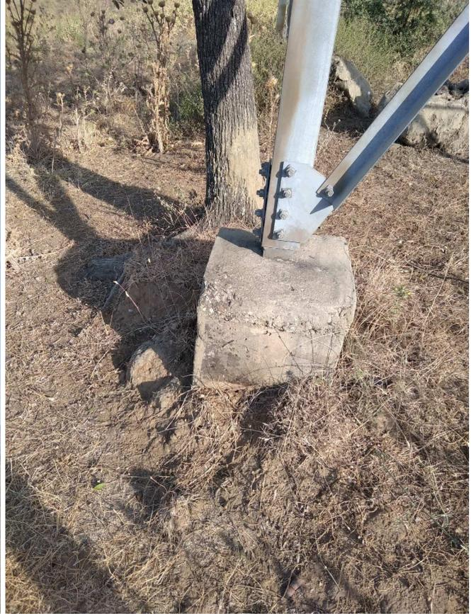
*Foto 4-17. Verticalità del sostegno 10 esistente (a sinistra) e particolare del plinto di fondazione nord-occidentale*
