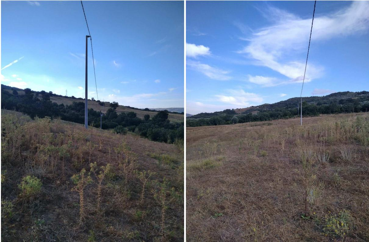
*Foto 4-16. Verticalità nell'elettrodotto della bassa tensione che attraversa trasversalmente il versante in prossimità del sostegno A17 (sinistra) e A16 (destra).*
