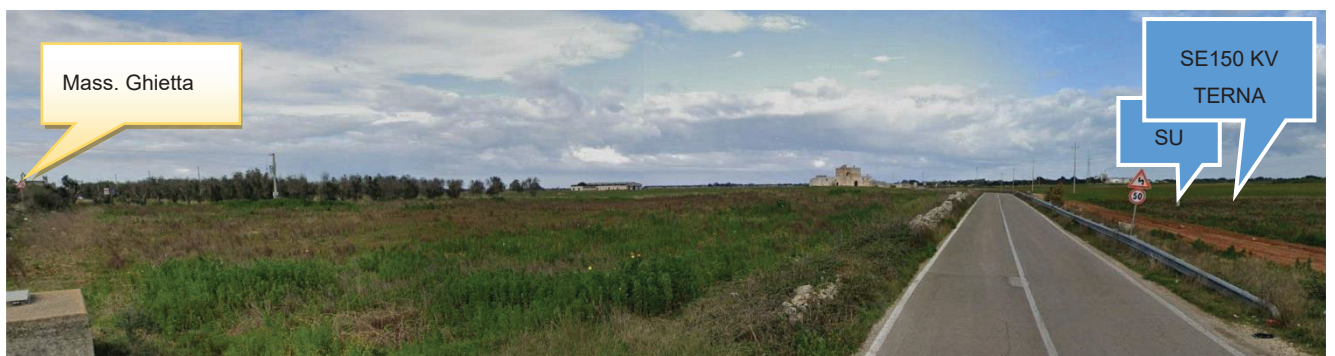
Figura 6-9: Vista da P1 – Post operam
