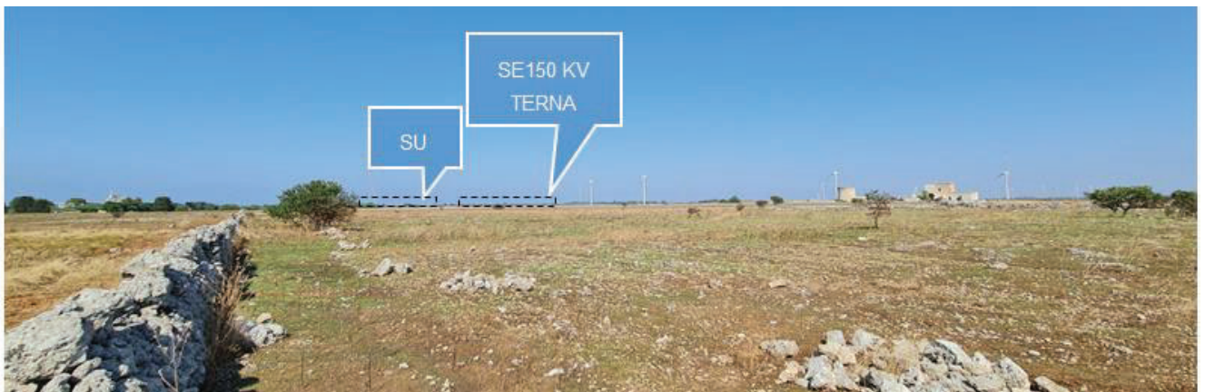
Figura 6-11: Vista da P3 – Post operam
