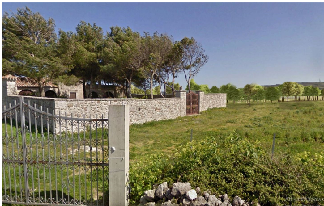
Foto 4 – panoramica Post Operam
