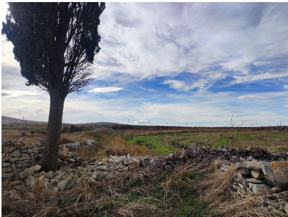
Confine aziendale con muretti a secco crollati
