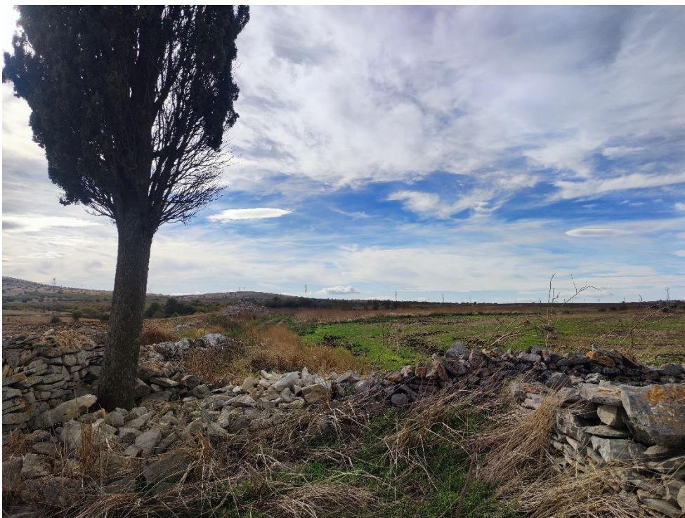
Confine aziendale con muretti a secco crollati
