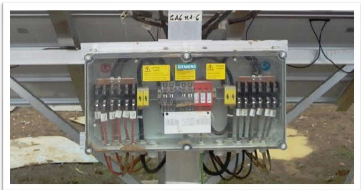
Figura 9 Esempio di string box
