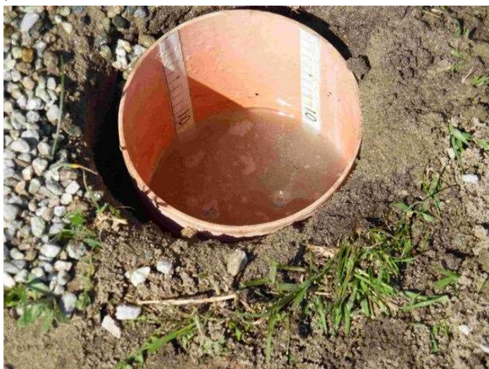
Prova di Permeabilità superficiale
