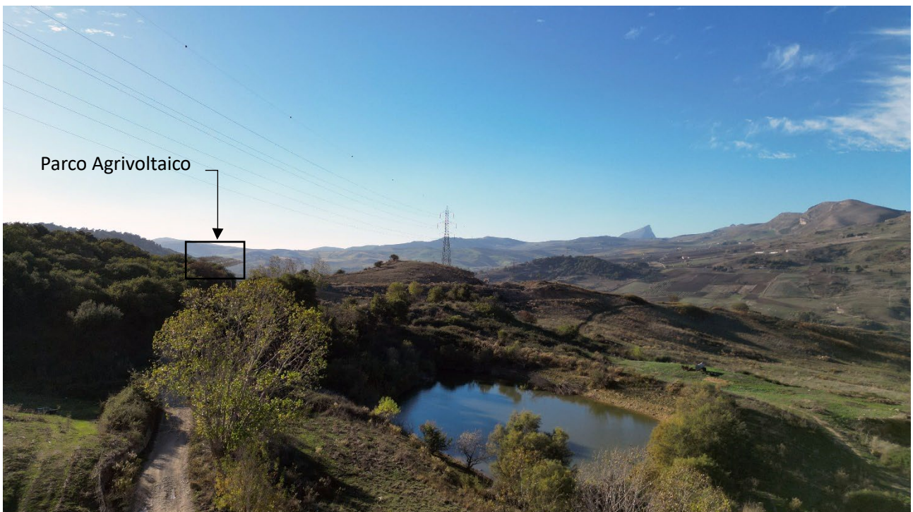
Figura 49 Punto di Ripresa 11 - post operam
