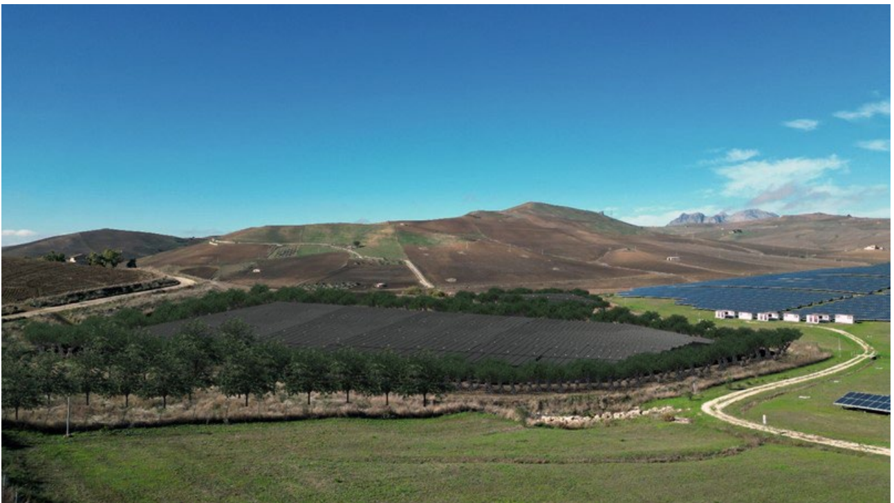
Figura 39 Punto di Ripresa 6 - post operam
