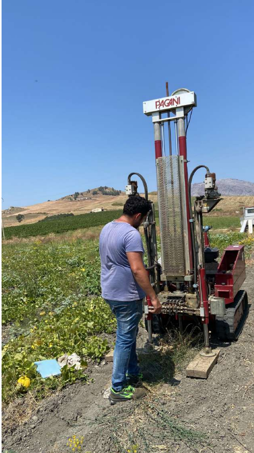
Prova DPSH 11 eseguita in situ
