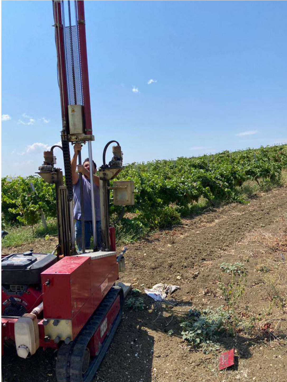
Prova DPSH 10 eseguita in situ
