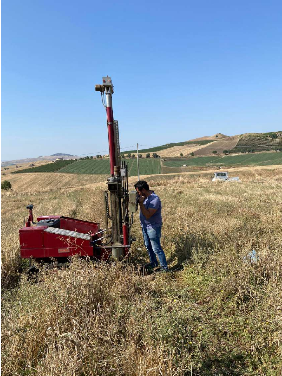
Prova DPSH 4 eseguita in situ
