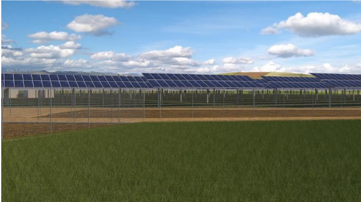
Esempio di impianti senza intervento di mitigazione
