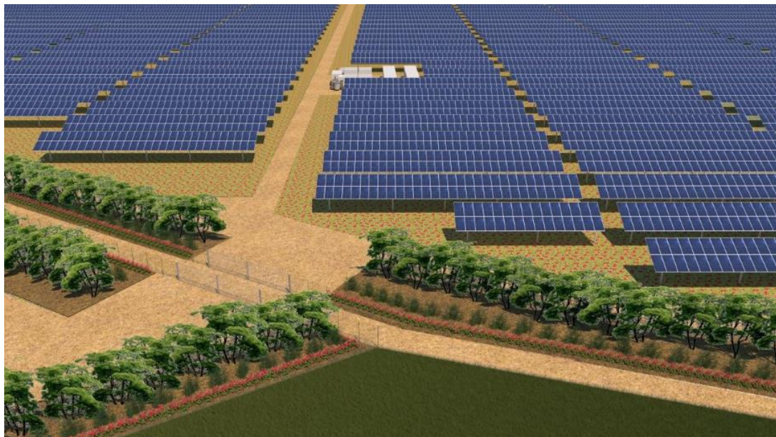
Esempio di impianti con fascia perimetrale di mitigazione visiva
