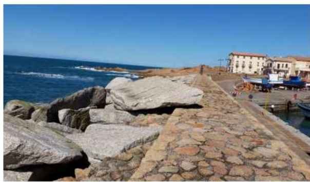
Figura 3 stato attuale: tracimazione a tergo della scogliera - Figura 4 stato attuale: elementi della mantellata in condizioni precarie
