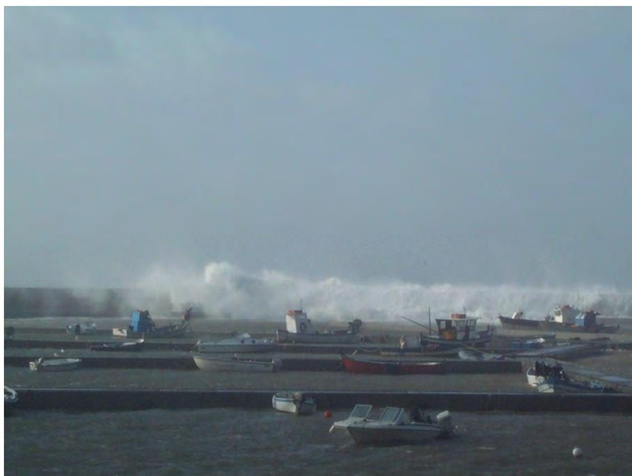
Figura 1: Sormonto del molo di sopraflutto.
