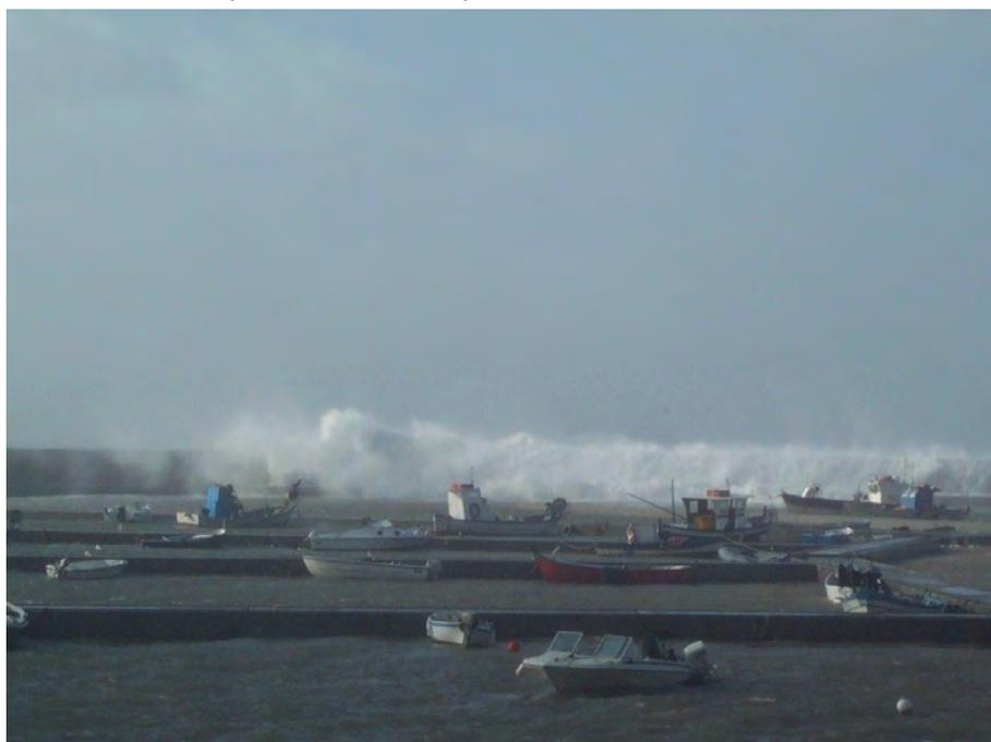
Figura 2: Sormonto del molo di sopraflutto.
