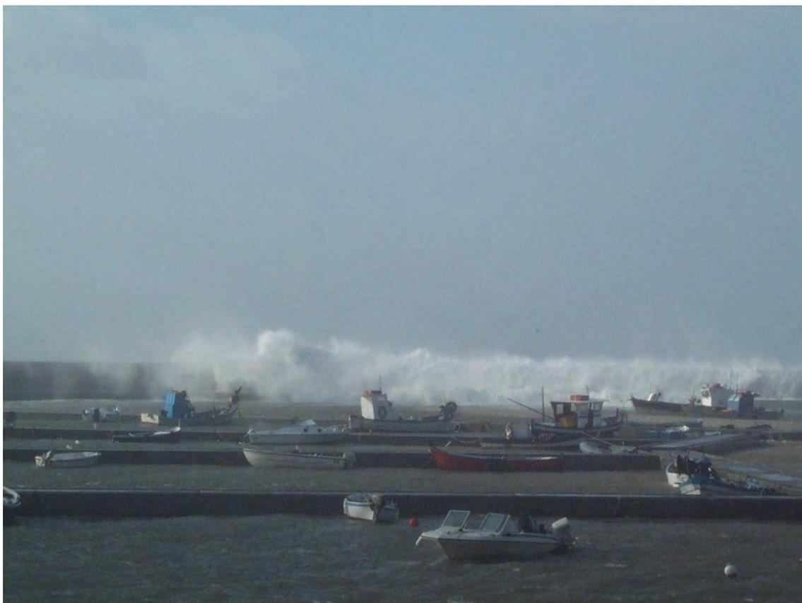
Figura 1: Sormonto del molo di sopraflutto.
