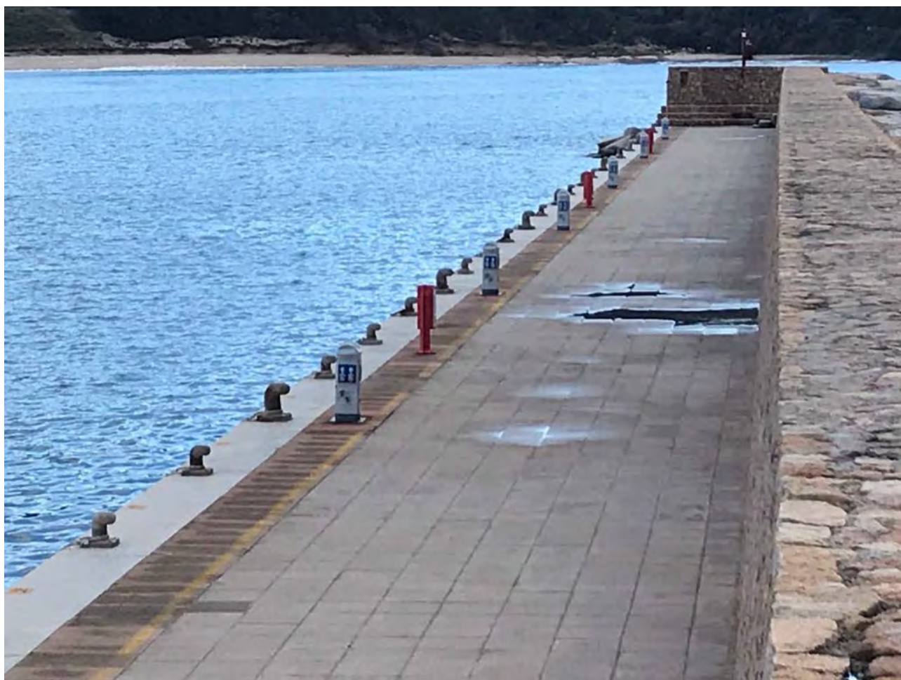
Figura 3: servizi presenti nella banchina perimetrale ovest.
