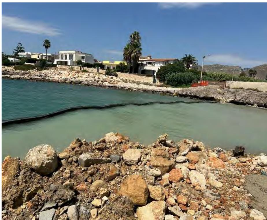
Figura 33: panne galleggianti per il contenimento della torbidità
