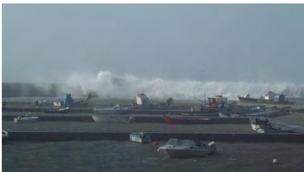
Figura 5: Sormonto del molo di sopraflutto
