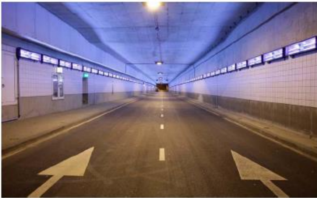
Figura 23. Applicazione lampade e vernice all'interno del tunnel
