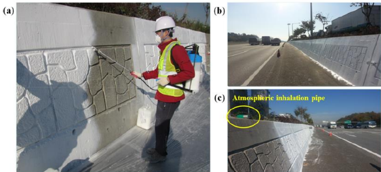
Figura 29. Applicazione vernice contenente \text{TiO}_2
