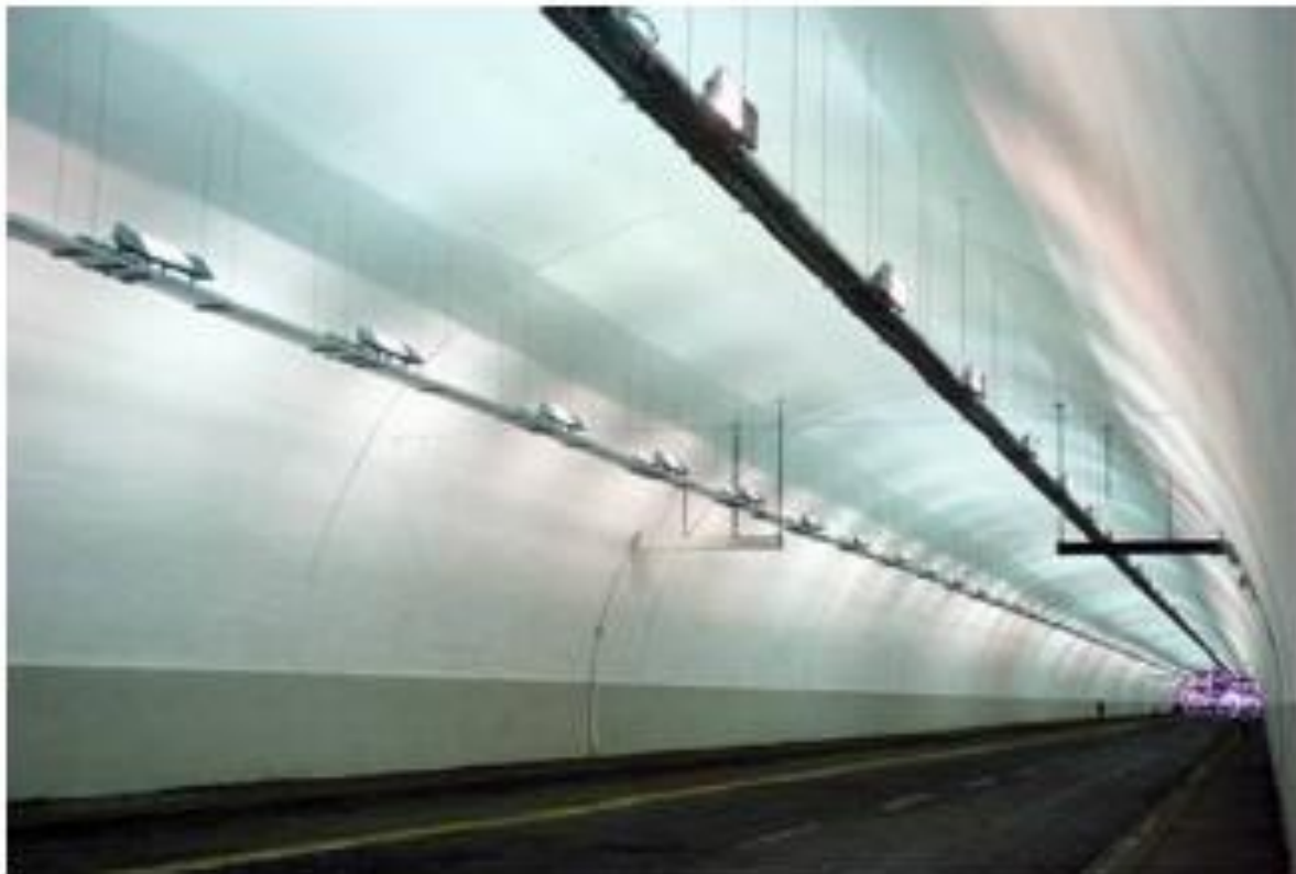
Figura 12. Vernice fotocatalitica all'interno del tunnel Umberto I
