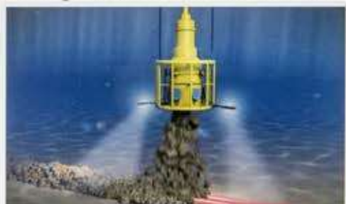
Figura 164. Esempio di protezione dei cavi mediante ricopertura con materiale lapideo.
