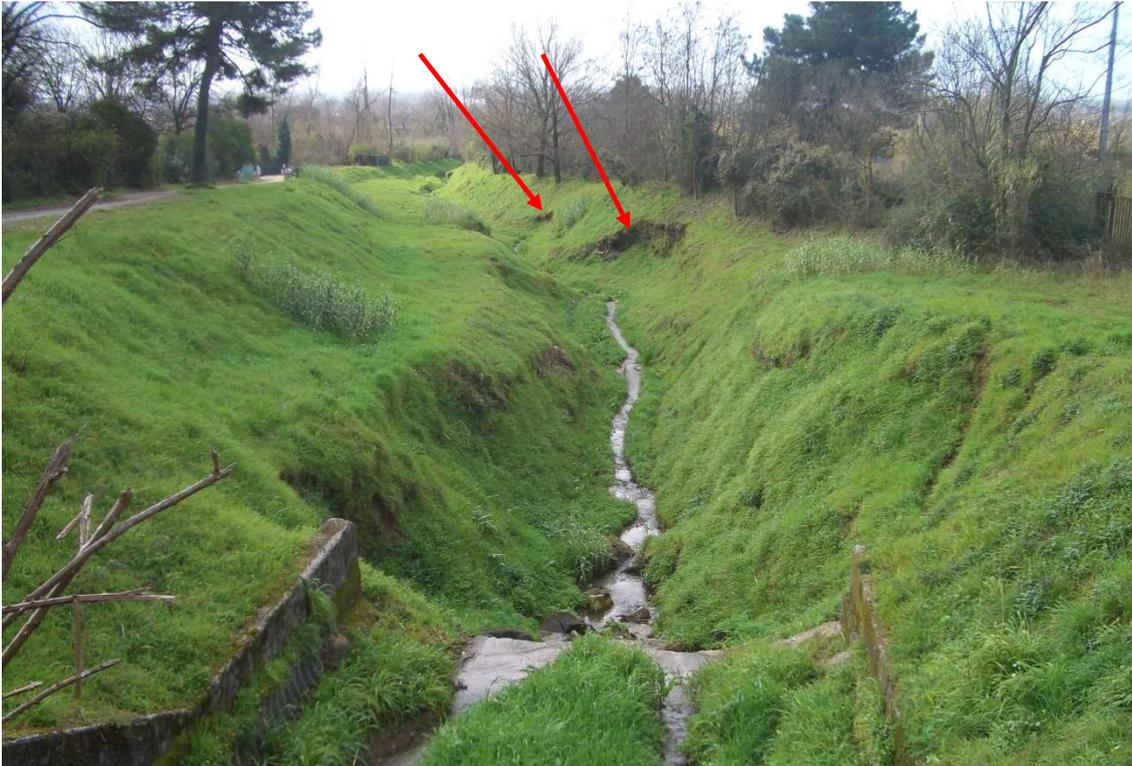
Fig. 4.10. Crolli lungo le sponde del T. Canal Magro innescati da erosione
