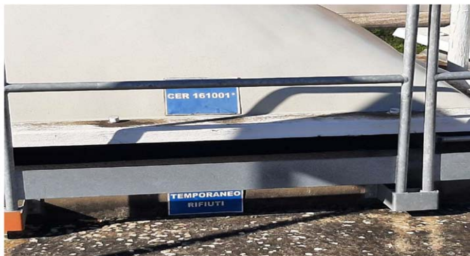
Figura 9. Serbatoio V07 per raccolta acque industriali gestite come rifiuto (EER 161001*), in deposito temporaneo
