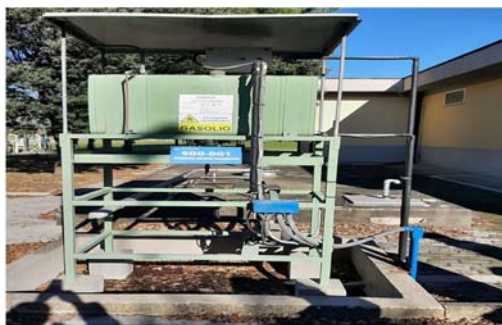
Figura 11. Serbatoio di gasolio giornaliero SGG-DG1 e serbatoio di gasolio V-2 al di sotto del piano campagna, in bacino di contenimento
