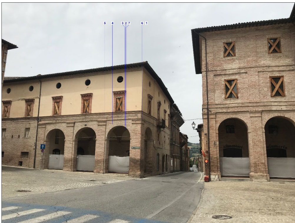
Figura 19– Punto POV4, Calderola, piazza al centro del paese (foto in direzione nord nord-ovest).
