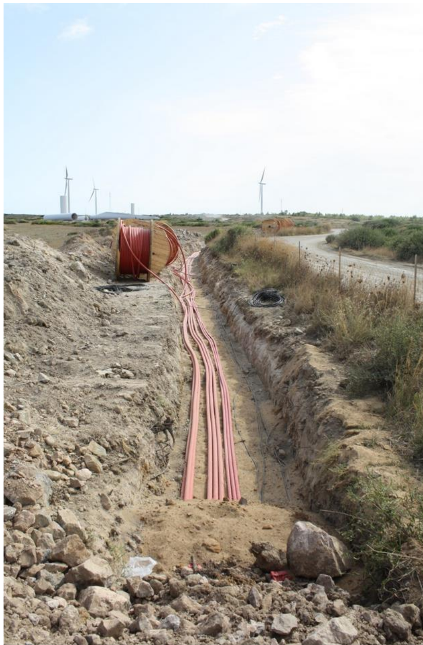
Figura 3.4 - Tipico scavo e linee interrante
