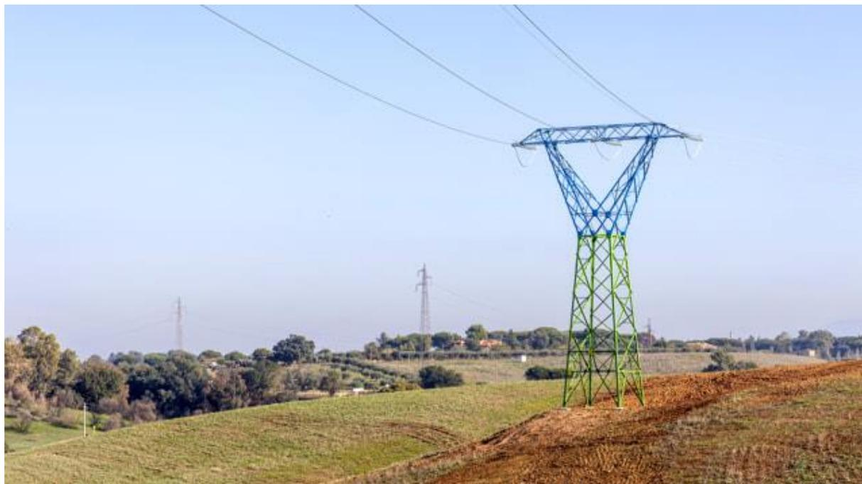
*Figura 4.27: esempio di sostegno di un elettrodotto ad AT*
