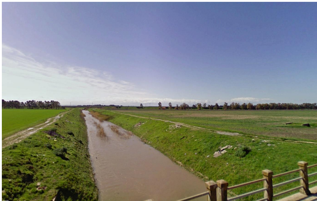
Figura 2.2: Il torrente Celone in prossimità dell'area di intervento.
