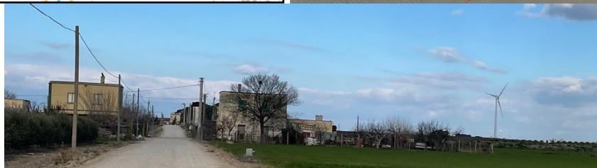
Figura 20 - Ricettore in prossimità del traliccio n.8
