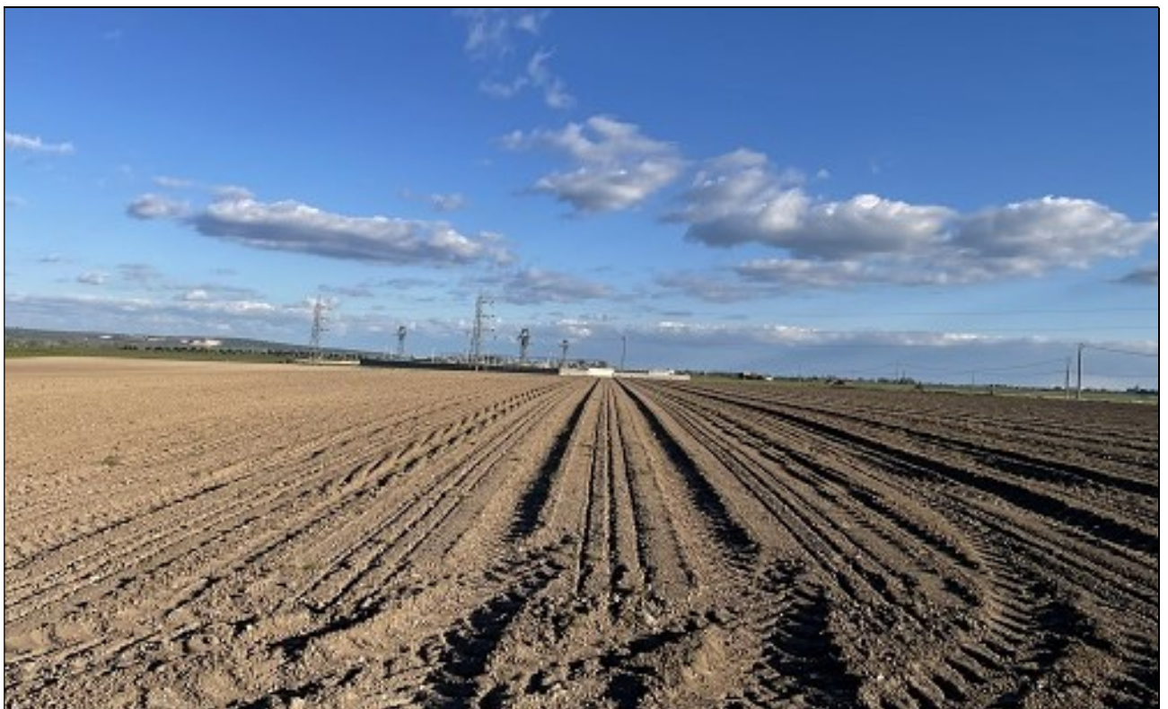
La SE 150 kV Innanzi, vista da Nord-Ovest
