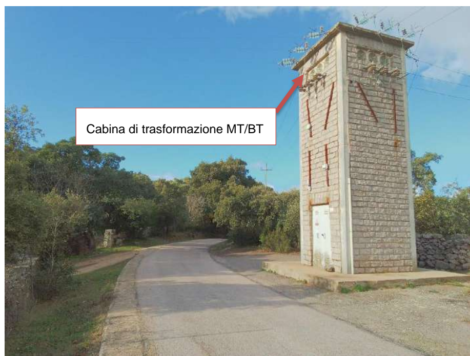
Figura 69-Cono 139_ Cabina di trasformazione (Coordinate UTM 32N 518120m E, 4529333m N)
