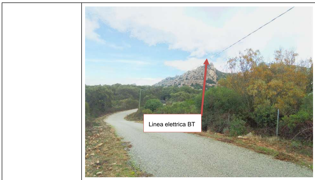
Figura 75-Cono 61_ Linea elettrica aerea (Coordinate UTM 32N 520685m E, 4530622m N)
