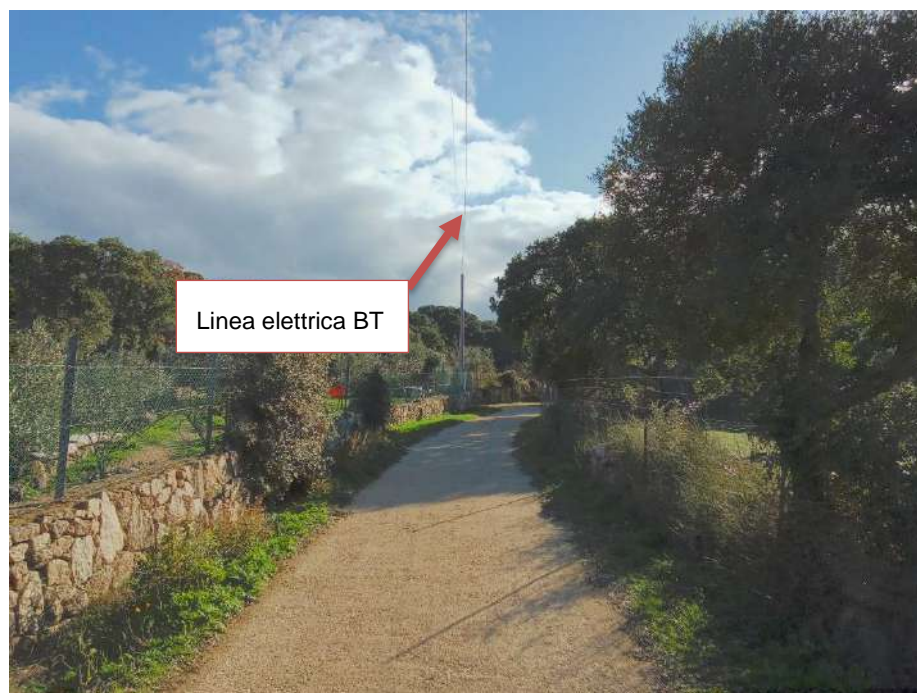
Figura 64-Cono 127_ Linea elettrica aerea (Coordinate UTM 32N 517375m E, 4530607m N)
