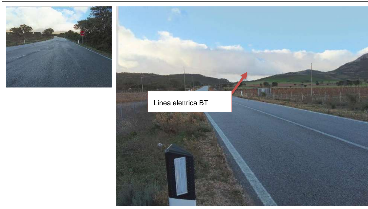
Figura 179-Cono 3_Linee elettriche (Coordinate UTM 32N 521565m E, 4522962m N)
