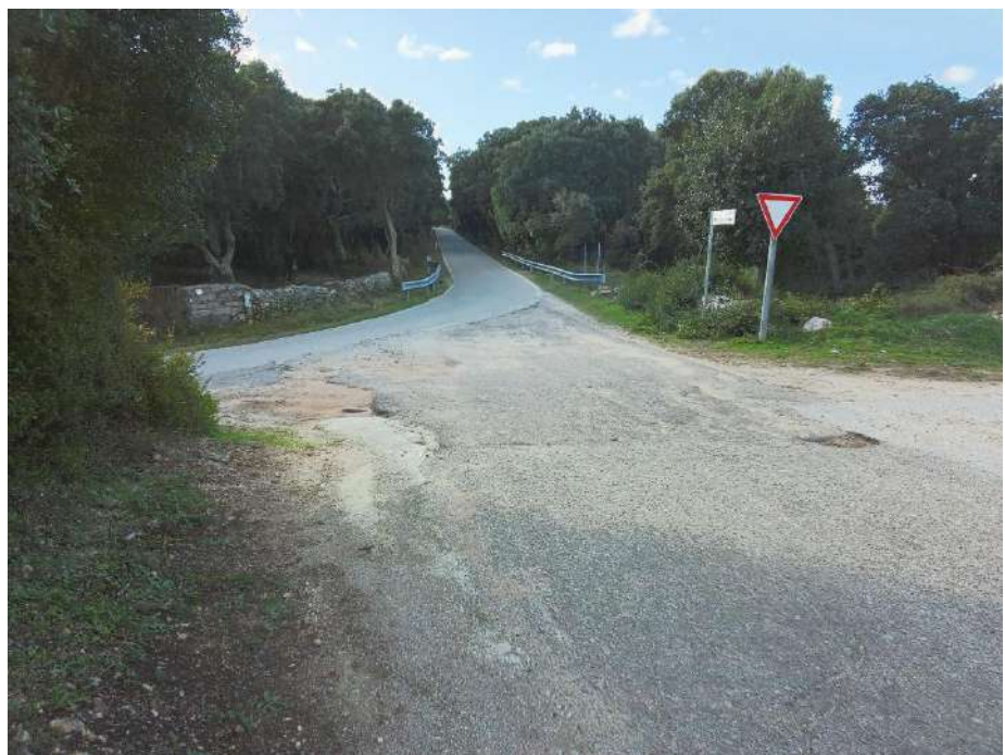
Figura 46-Cono 107_Tratto stradale con raggio di curvatura ristretto (Coordinate UTM 32N 517865m E, 4531866m N)
