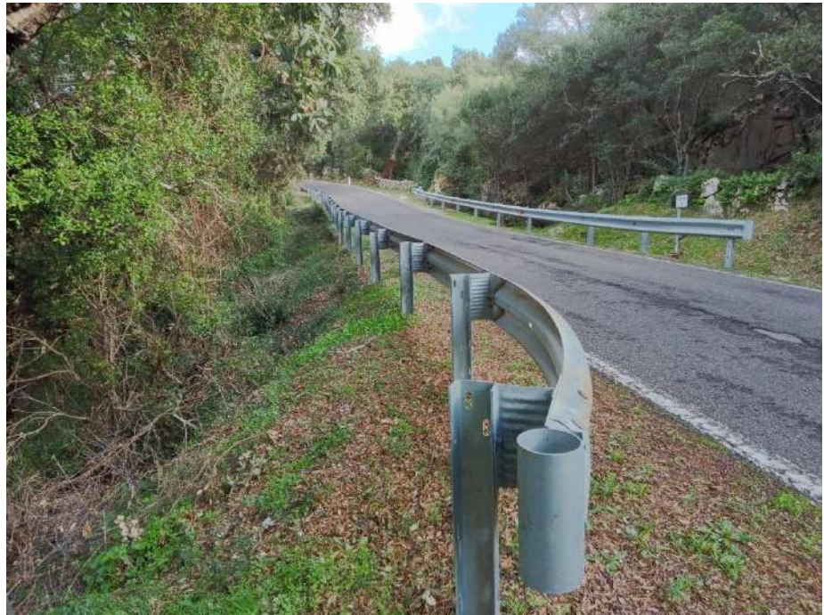
Figura 45-Cono 110_Tratto stradale con raggio di curvatura ristretto (Coordinate UTM 32N 517559m E, 4531547m N)
