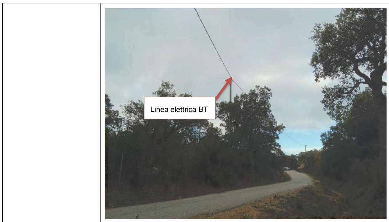
Figura 74-Cono 60_ Linea elettrica aerea (Coordinate UTM 32N 520593m E, 4530511m N)
