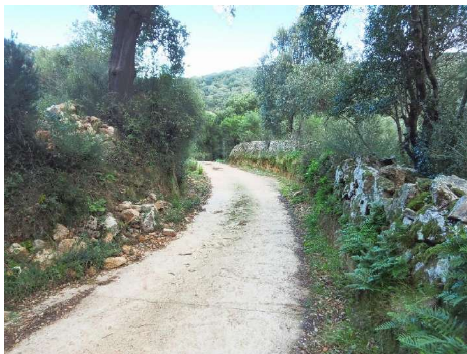
Figura 32-Cono 120_Tratto stradale con pendenza elevata (Coordinate UTM 32N 517543m E, 4530844m N)
