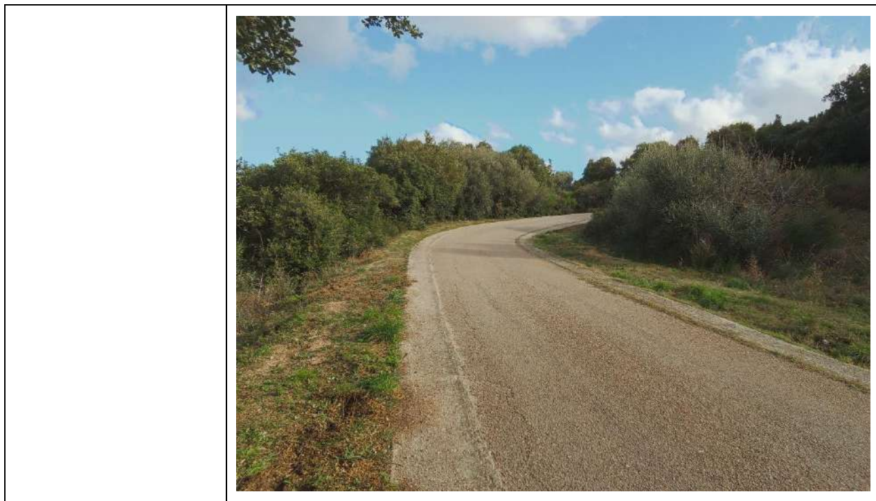
Figura 39-Cono 88_Tratto stradale con pendenza elevata (Coordinate UTM 32N 518489m E, 4533762m N)
