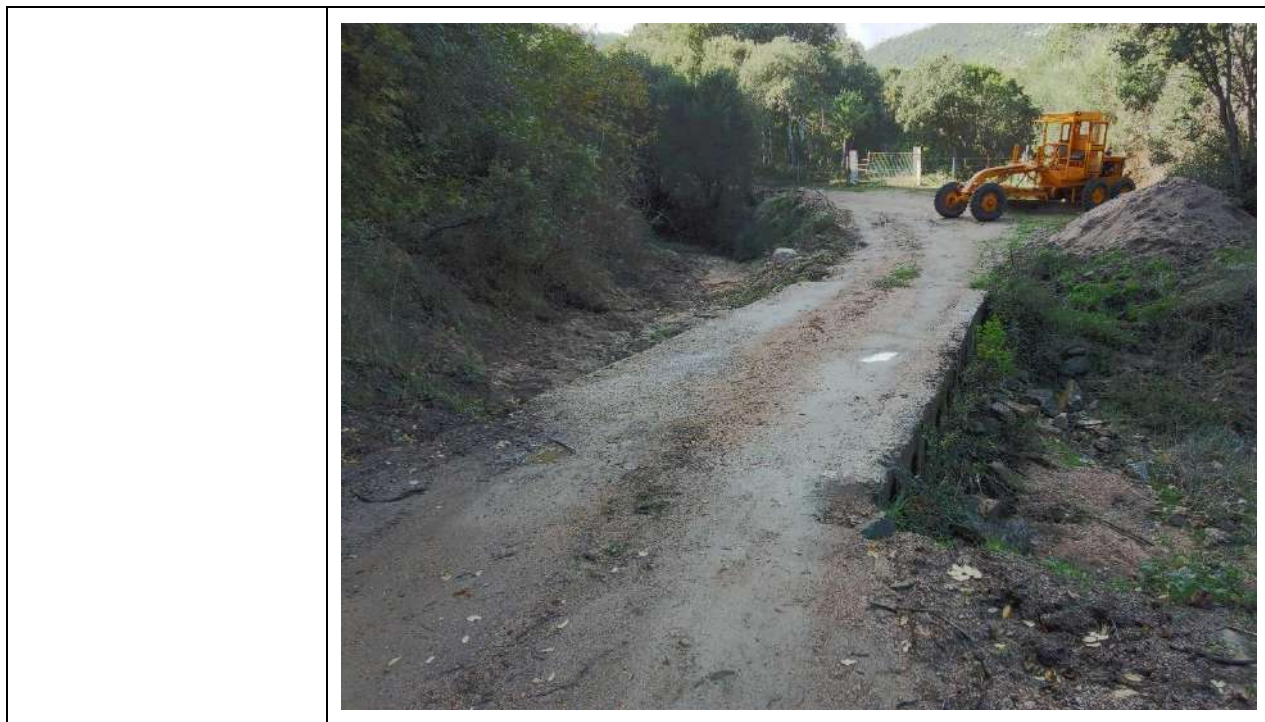
Figura 184-Cono 33_ Attraversamento fluviale (Coordinate UTM 32N 523267m E, 4529316m N)
