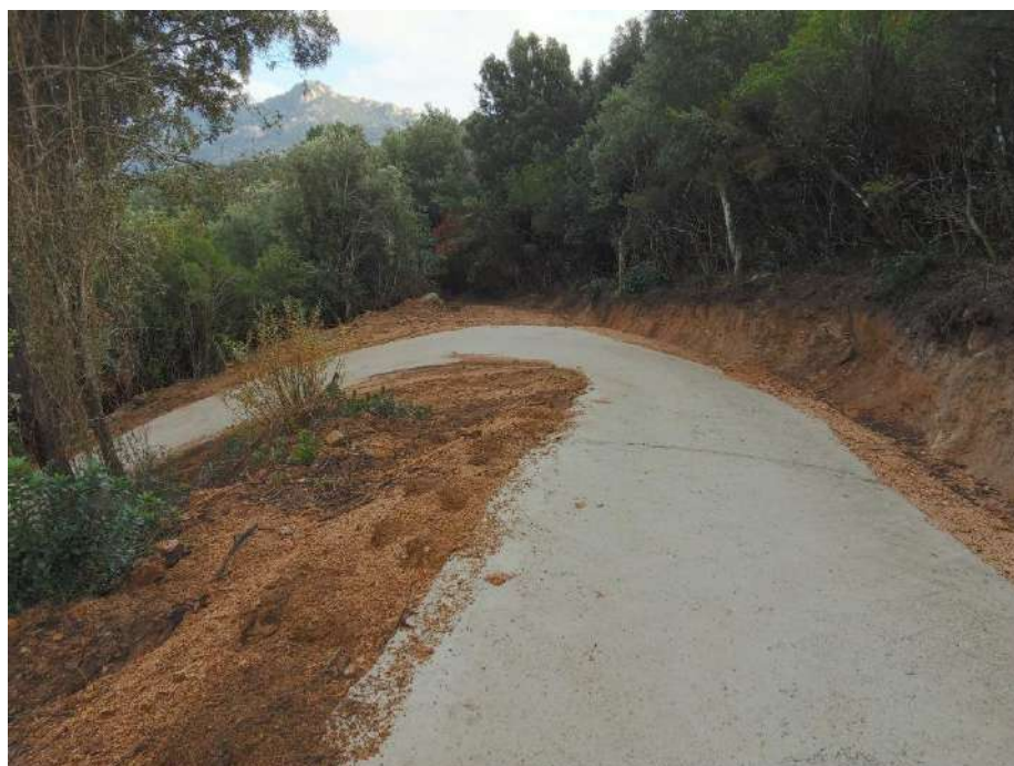
Figura 165-Cono 39_ Tratto stradale con pendenza elevata e con ridotto raggio di curvatura (Coordinate UTM 32N 522117m E, 4528732m N)
