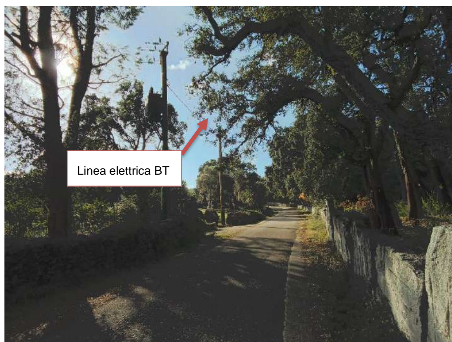
Figura 61-Cono 105_ Linea elettrica aerea (Coordinate UTM 32N 517994m E, 4532100m N)
