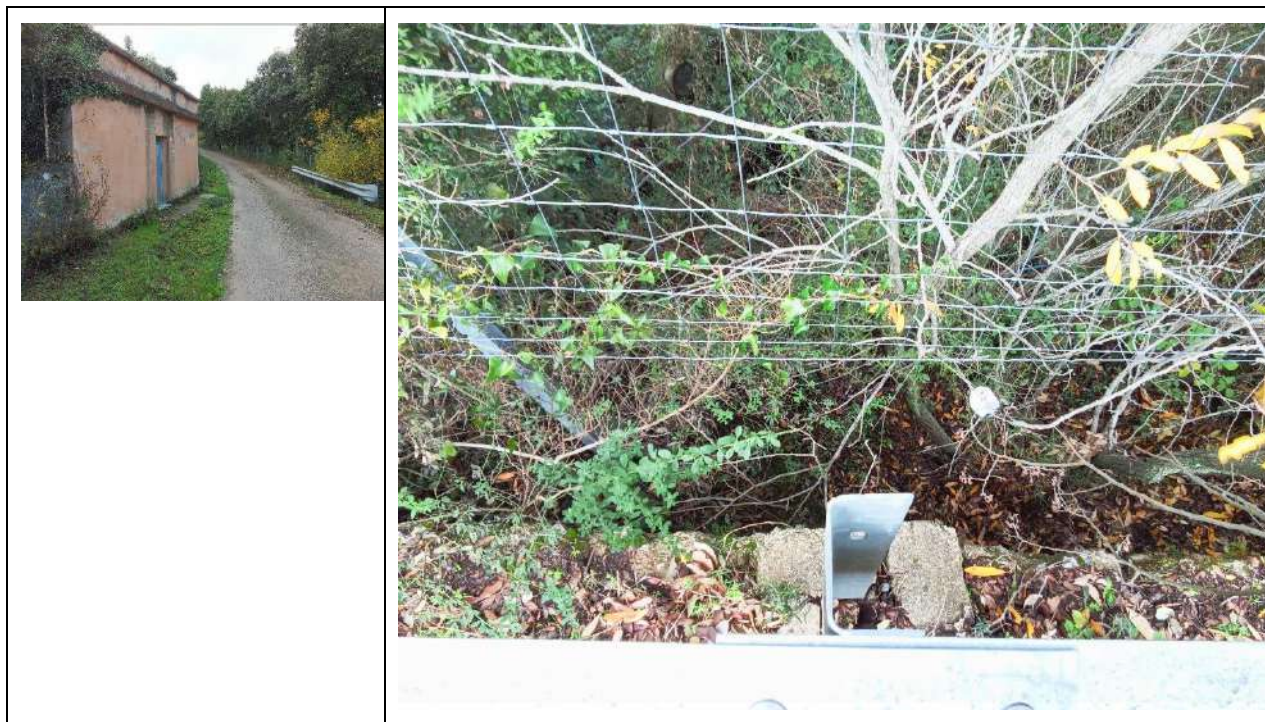
Figura 177-Cono 42_ Ponte in zona acquedotto (Coordinate UTM 32N 521632m E, 4528754m N)
