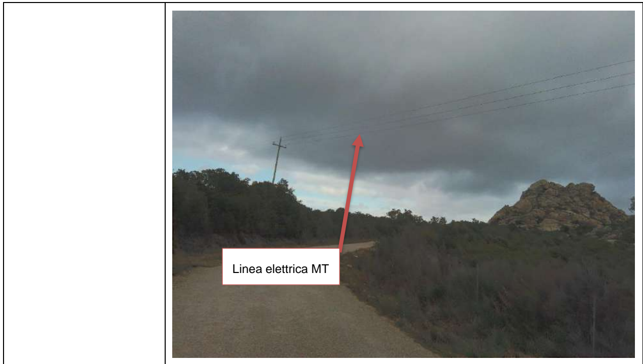
Figura 72-Cono 59_ Linea elettrica aerea (Coordinate UTM 32N 520462m E, 4530383m N)
