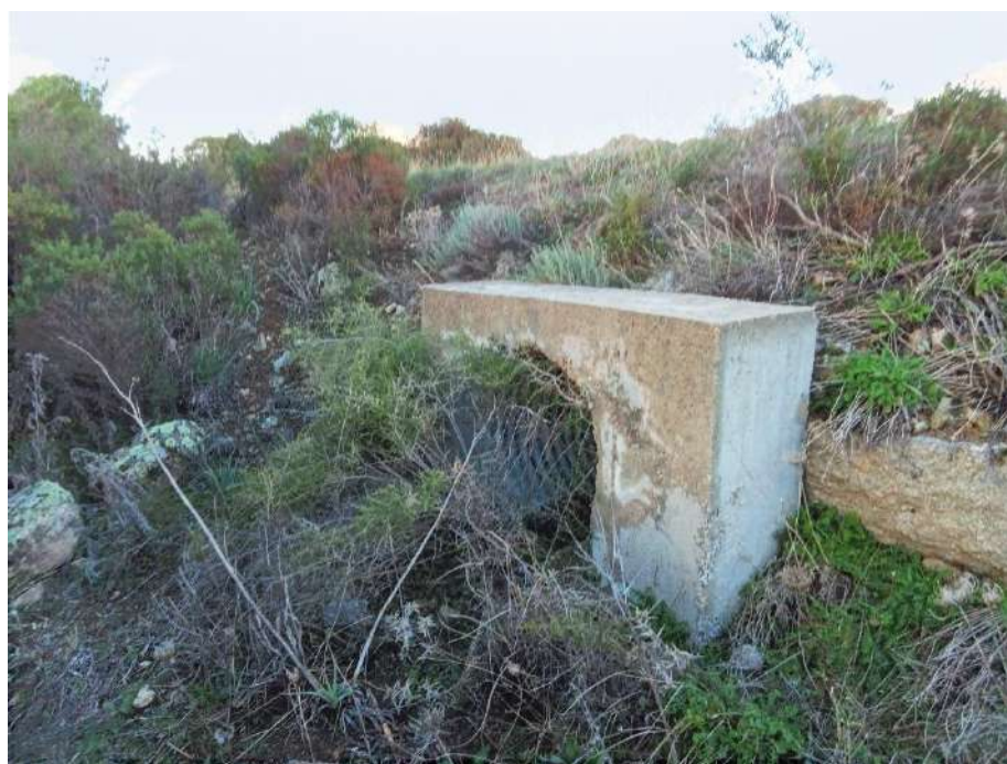
Figura 153 – Cono 7_ Opera idraulica stradale (Coordinate UTM 32N 521948m E, 4524333m N)
