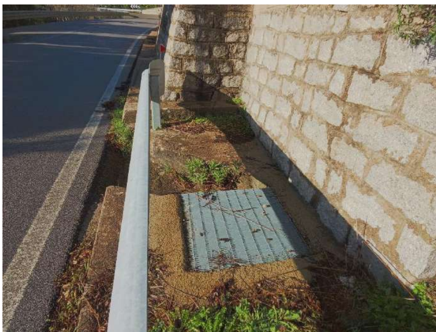
Figura 146 – Cono 22_Chiusino afferente al probabile passaggio delle condotte di drenaggio delle acque meteoriche
