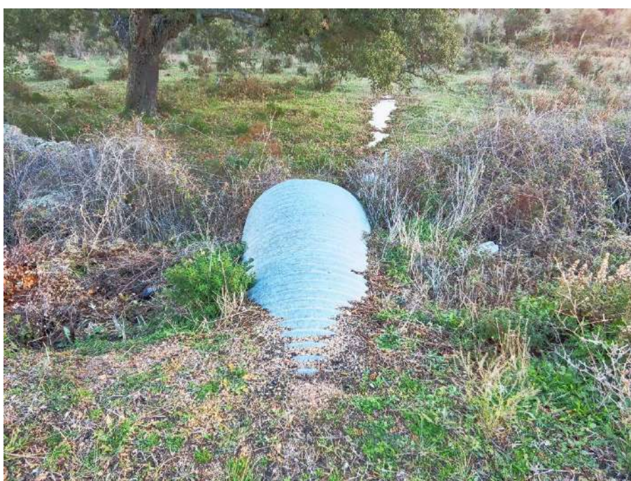
Figura 151 – Cono 4_ Opera idraulica stradale (Coordinate UTM 32N 521529m E, 4523132m N)
