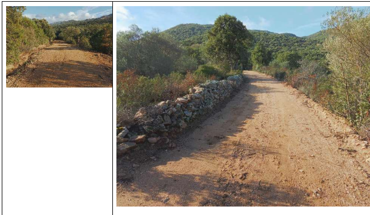
Figura 186-Cono 35_ muretto a secco e pendenza elevata del tracciato stradale (Coordinate UTM 32N 523131m E, 4529209m N)
