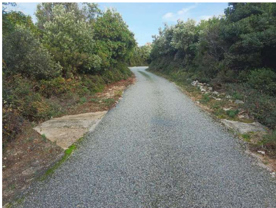
Figura 10 - Cono 69_ Opera idraulica stradale (Coordinate UTM 32N 521804m E, 4531107m N)
