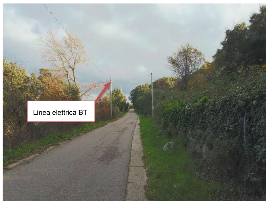
Figura 66-Cono 133_ Linea elettrica aerea (Coordinate UTM 32N 517136m E, 4530211m N)
