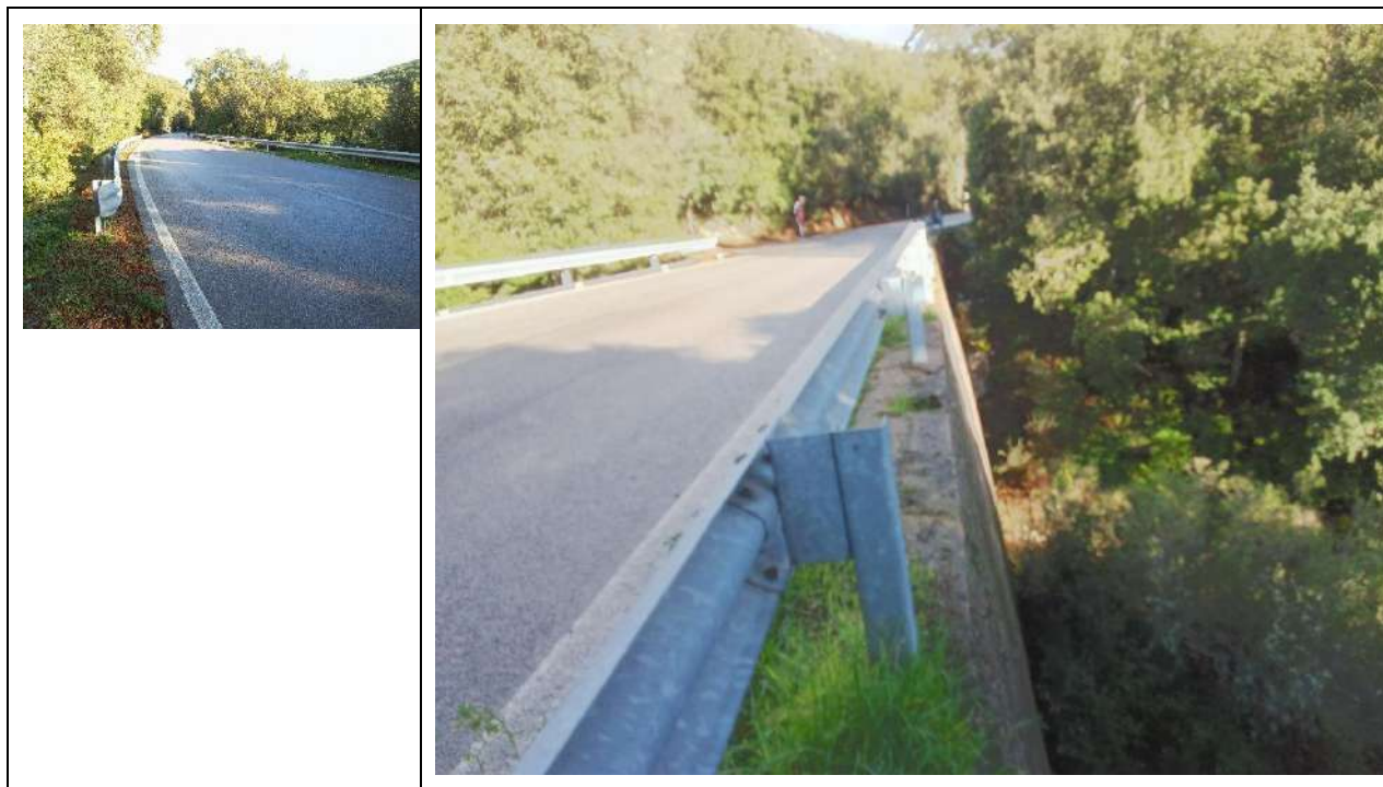
Figura 174-Cono 24_ Ponte (Coordinate UTM 32N 522219m E, 4527001m N)
