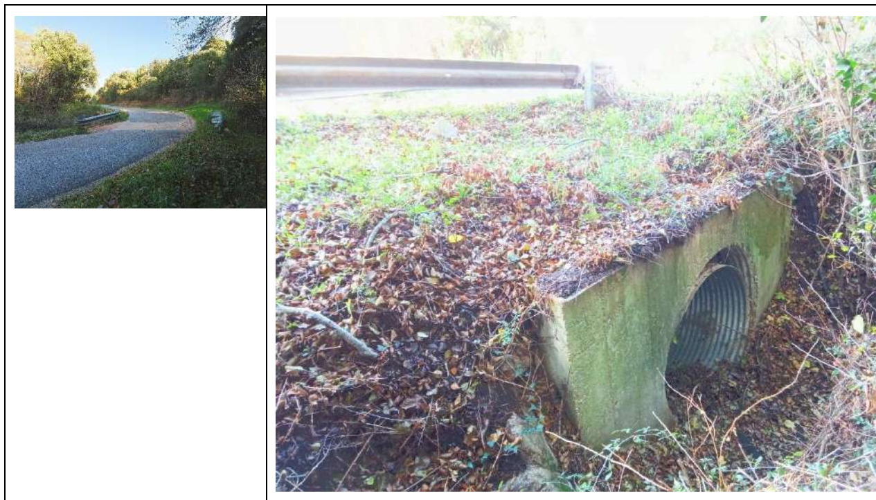
Figura 155 - Cono 29_ Opera idraulica stradale (Coordinate UTM 32N 523048m E, 4528689m N)
