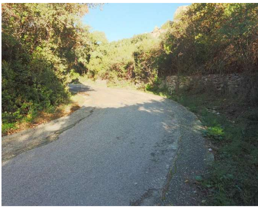
Figura 47-Cono 98 _Tratto stradale con raggio di curvatura ristretto (Coordinate UTM 32N 518329m E, 4532866m N)
