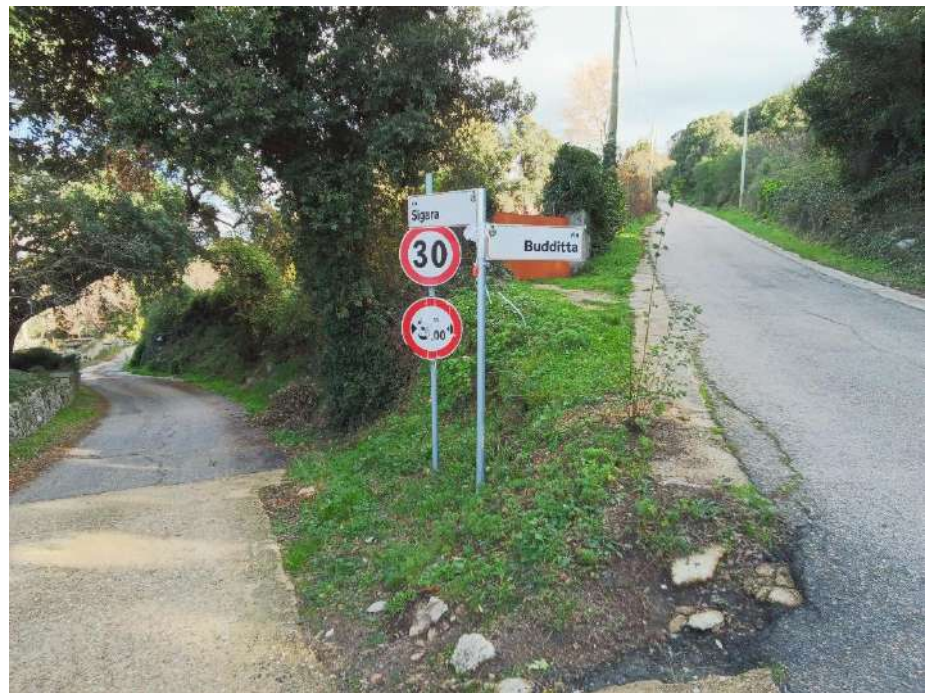
Figura 28-Cono 132_Tratto stradale con pendenza elevata e con ridotto raggio di curvatura (Coordinate UTM 32N 517119m E, 4530219m N)
