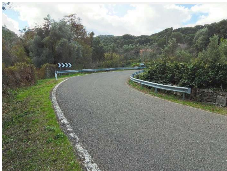
Figura 44-Cono 114_ Tratto stradale con raggio di curvatura ristretto (Coordinate UTM 32N 517650m E, 4530981m N)
