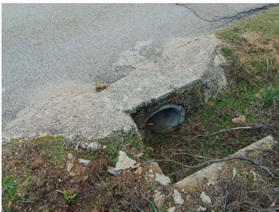
Figura 11 - Cono 152_ Opera idraulica stradale (Coordinate UTM 32N 522987m E, 4532145m N)
