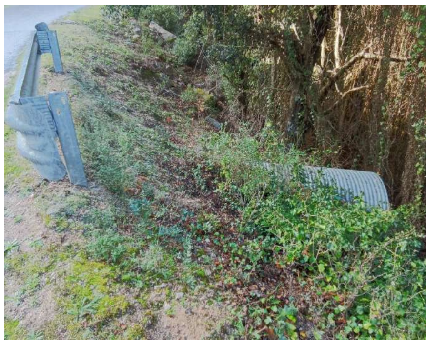
Figura 154 - Cono 28_ Opera idraulica stradale (Coordinate UTM 32N 522963m E, 4528292m N)
