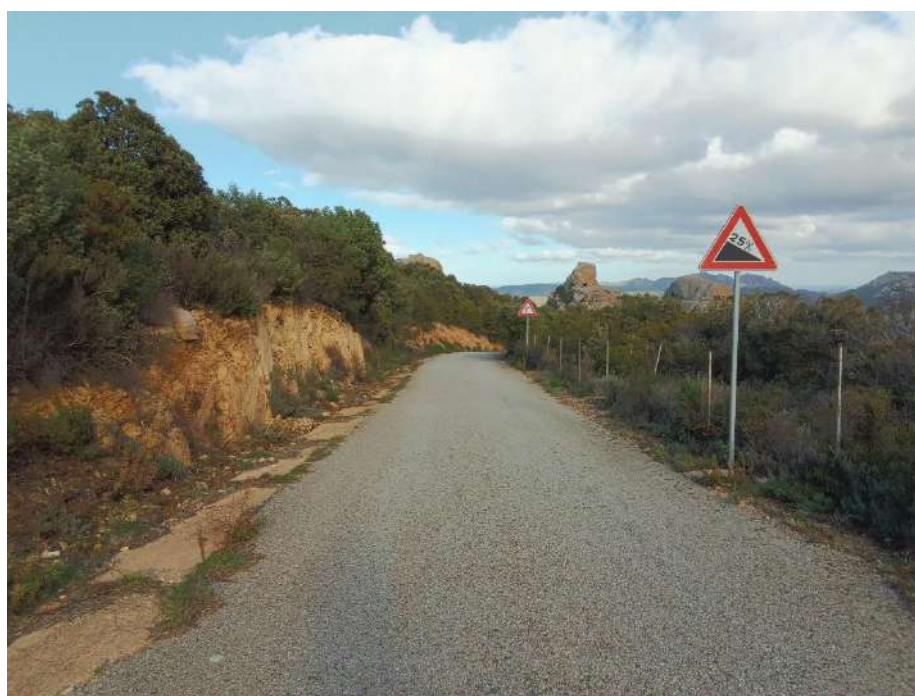
Figura 24-Cono 144_Tratto stradale con pendenza elevata (Coordinate UTM 32N 522607m E, 4532085m N)
