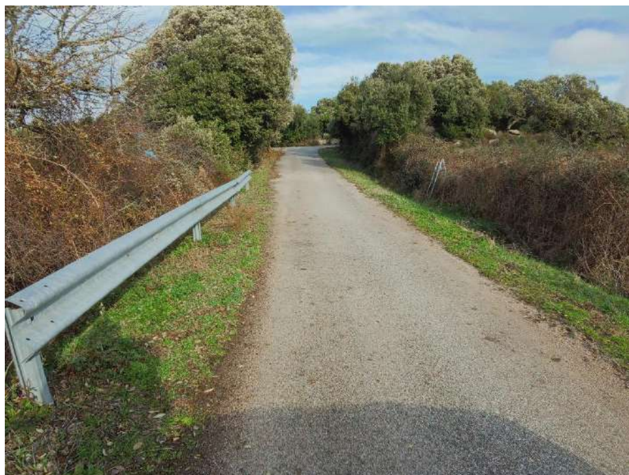
Figura 17-Cono 47_Tracciato stradale di ampiezza inferiore ai 4m (Coordinate UTM 32N 519471m E, 4529853m N)
