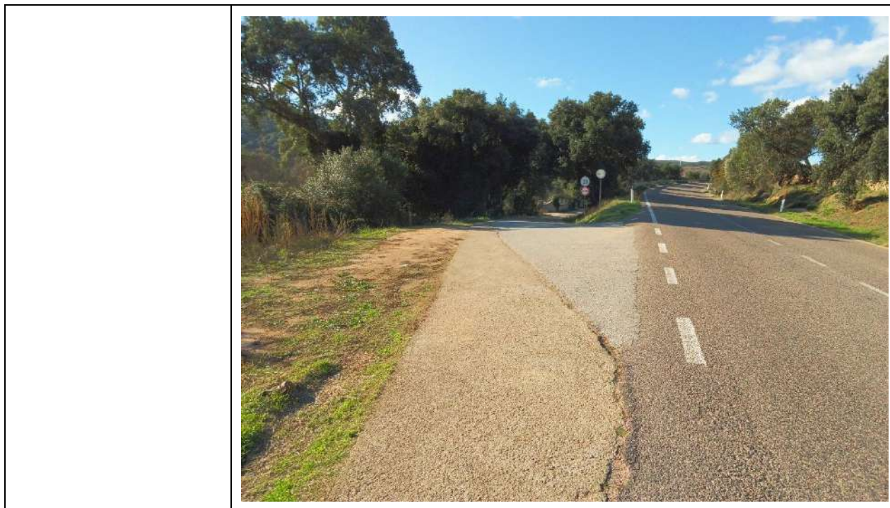
Figura 51-Cono 74_ Tratto stradale con raggio di curvatura ristretto (Coordinate UTM 32N 518907m E, 4534849m N)
