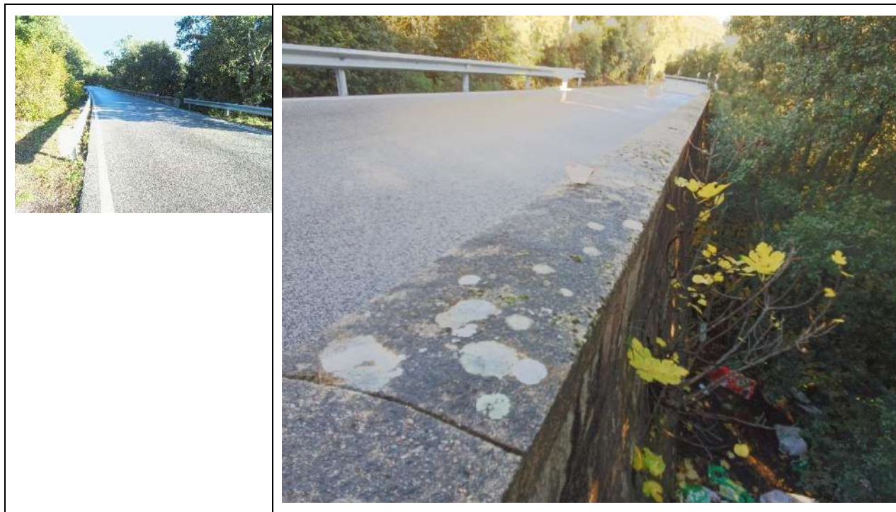
Figura 170-Cono 20_ Ponte/viadotto (Coordinate UTM 32N 522035m E, 4526668m N)
