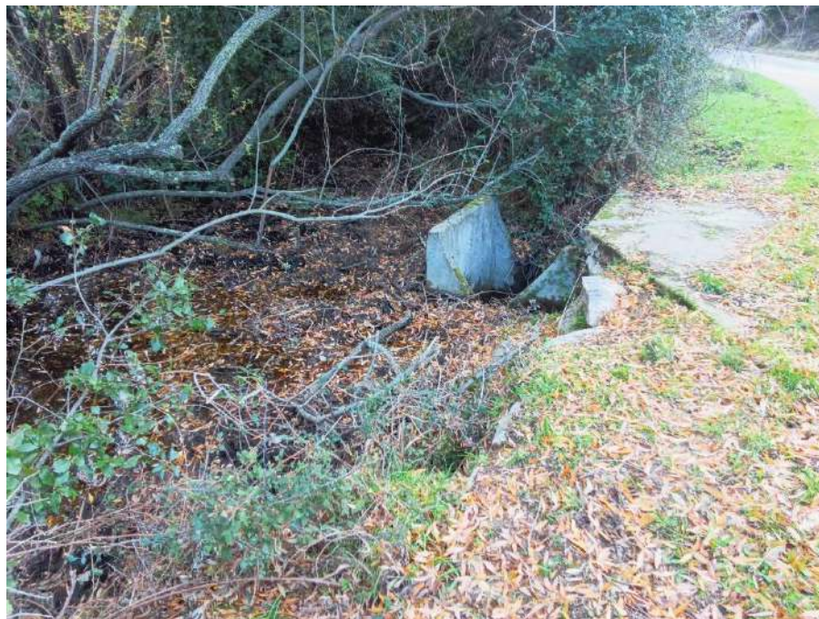
Figura 9 - Cono 64_ Opera idraulica stradale (Coordinate UTM 32N 521067m E, 4530889m N)
