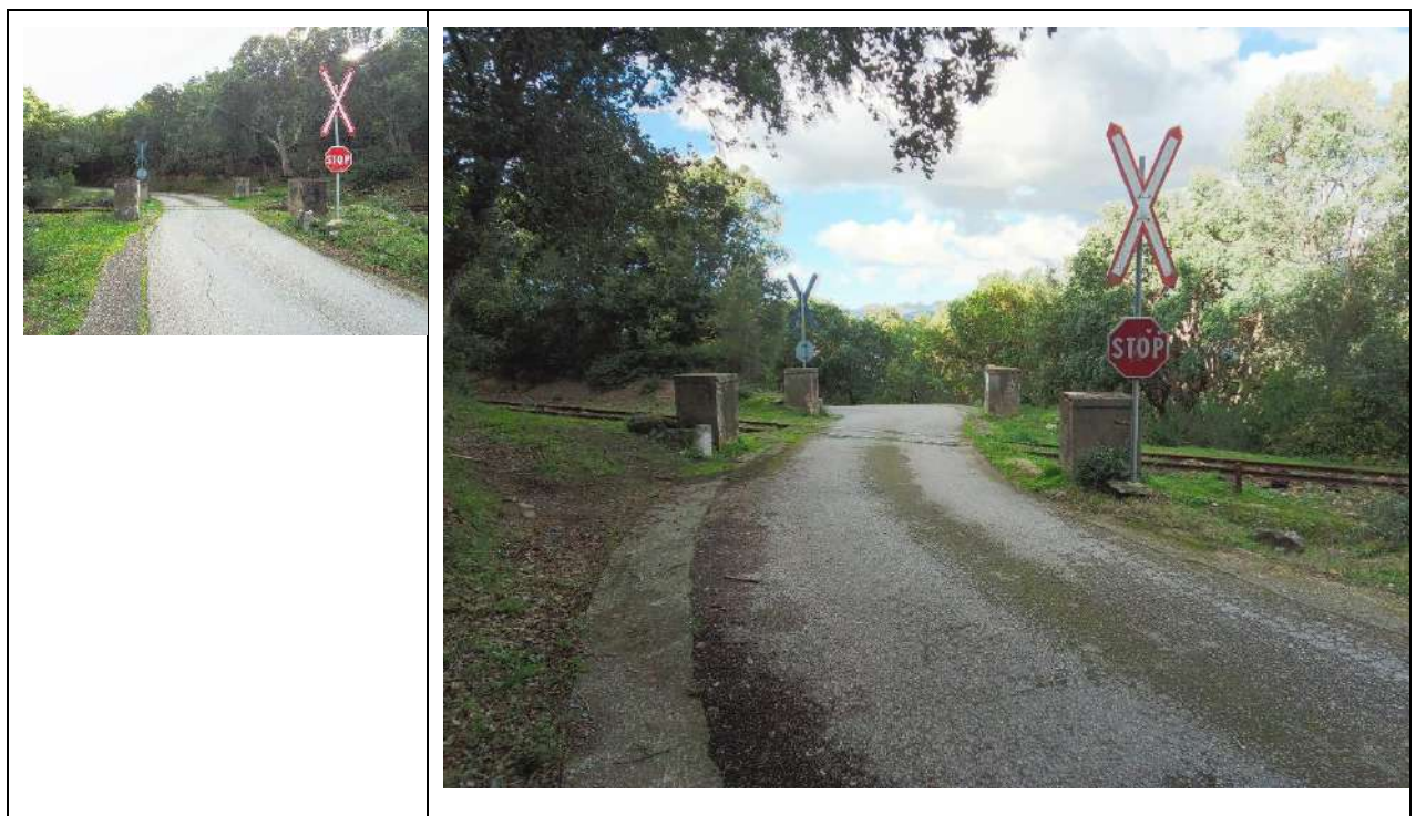
Figura 53-Cono 85_Restringimento dovuto alla presenza dei pilastri di segnalazione dell' attraversamento
