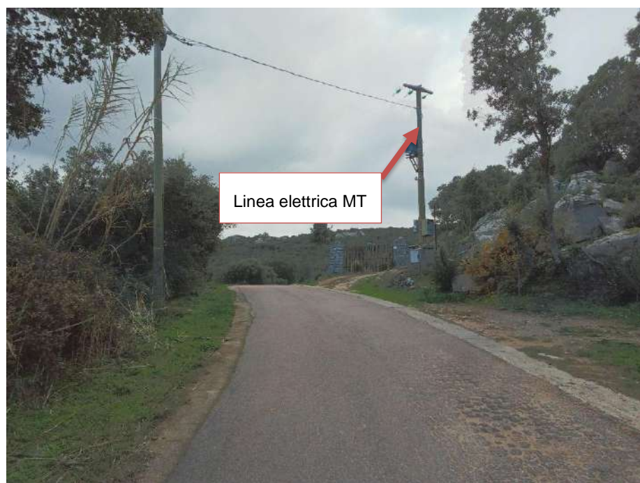
Figura 67-Cono 135_ Linea elettrica aerea (Coordinate UTM 32N 517502m E, 4529963m N)
