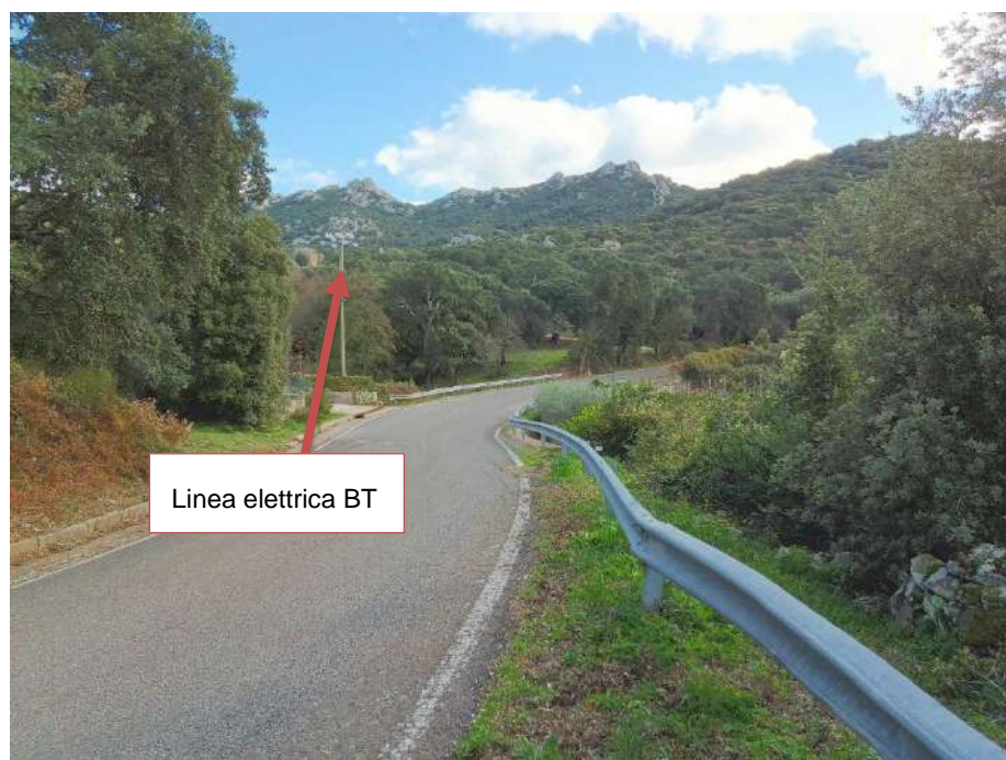
Figura 63-Cono 113_ Linea elettrica aerea (Coordinate UTM 32N 517569m E, 4531083m N)
