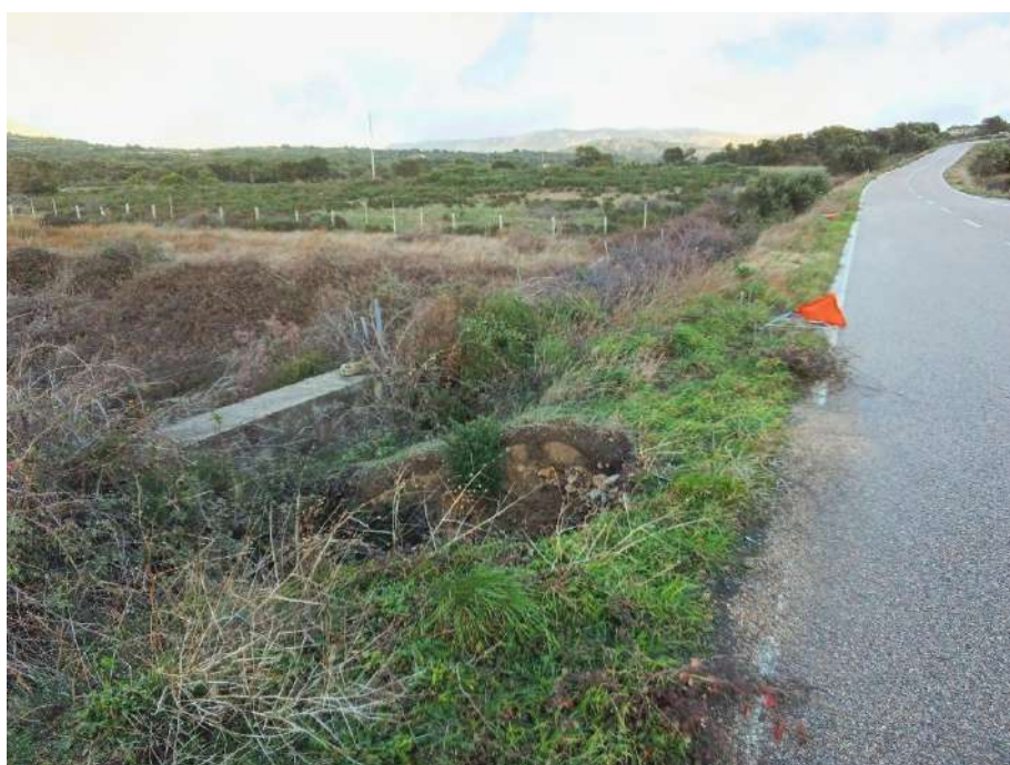
Figura 152 – Cono 5_ Opera idraulica stradale (Coordinate UTM 32N 521638m E, 4523707m N)
