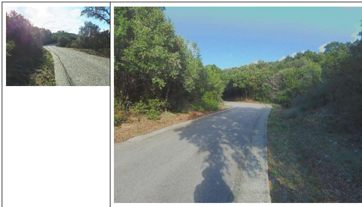
Figura 49-Cono 95_Tratto stradale con raggio di curvatura ristretto (Coordinate UTM 32N 518253m E, 4533131m N)
