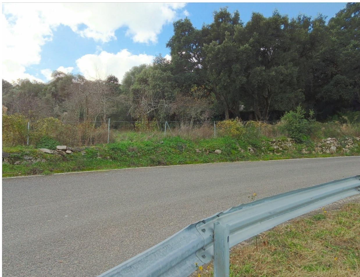
Figura 53: Cono di ripresa 116 verso inizio tratto di nuova vabilità.
