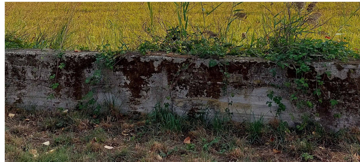
FOTO 19 - Muro di confine esistente in CLS h 50cm
