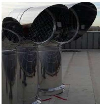
In ragione del tipo di isolamento ( 100 mm ) fornito, si prevedono le seguenti temperature di superficie della canna fumaria ( considerando un flusso fumi continuativo di 10.983 kg/h a 478 °C):
