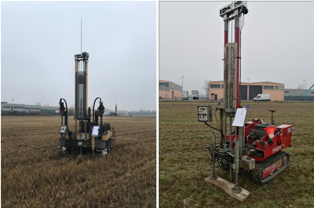
Esecuzione delle prove SCPT
