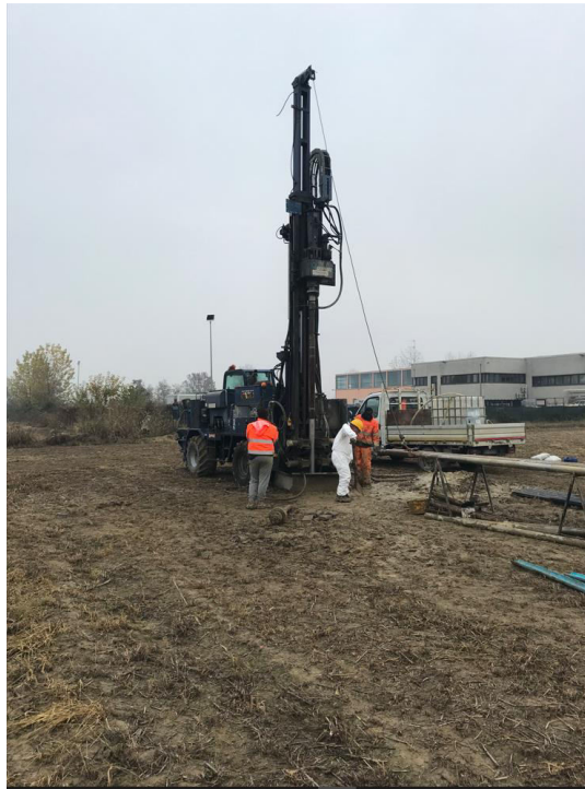
Esecuzione dei sondaggi
