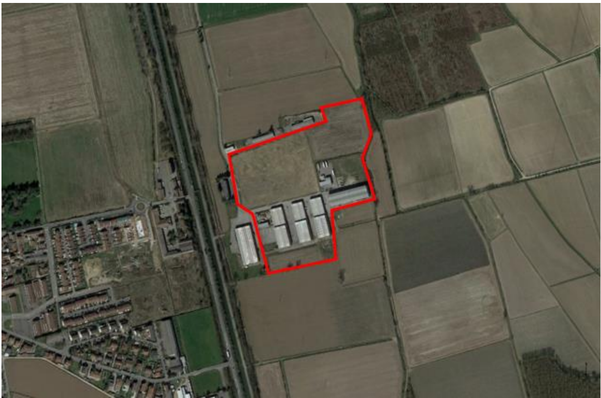
Figura 1: Area d’intervento per la costruzione del nuovo Data Center
