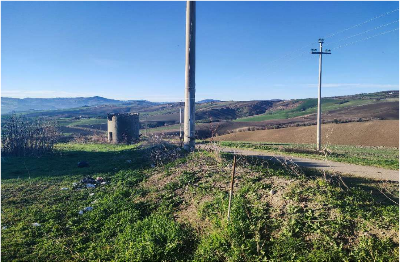
Fig. 49 Punto di presa n. 10.c stato di fatto (Masseria Graziani)
