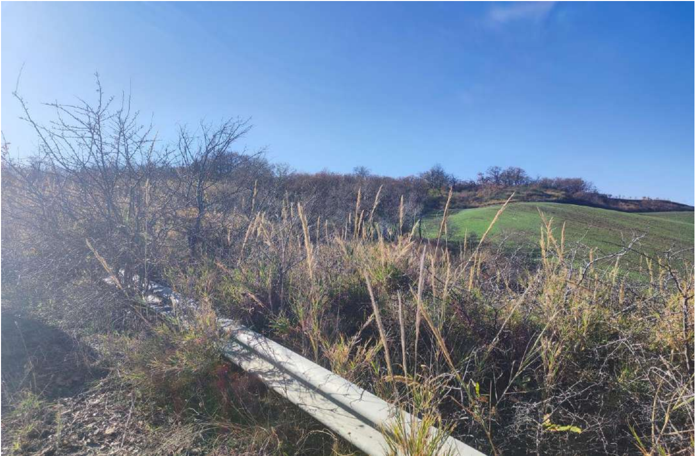
Fig. 173 Punto di presa n. 10 stato di fatto (Tratturo Centurelle - Montesecco)
