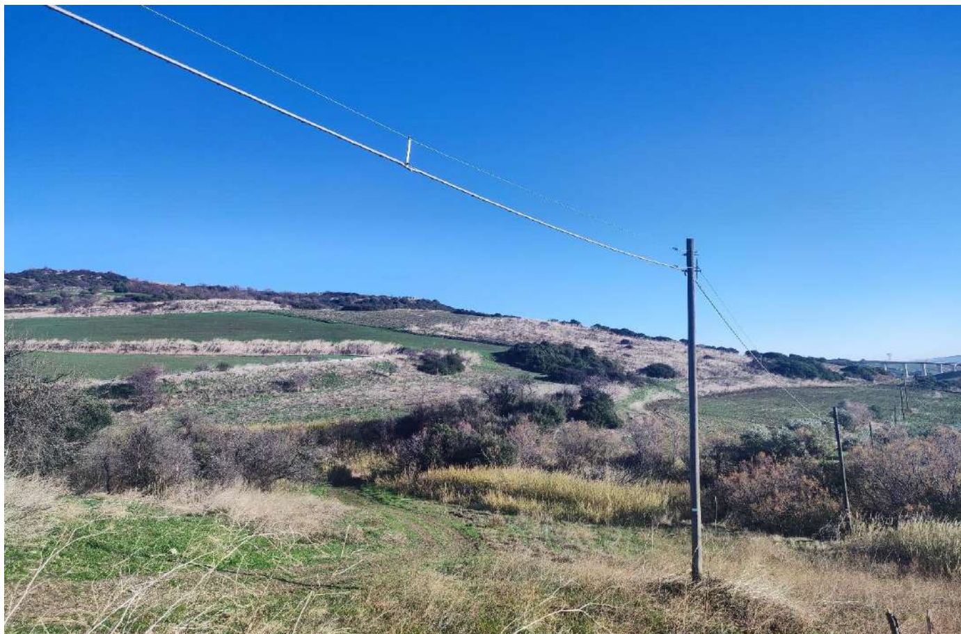
Fig. 15 Punto di presa n. 4 stato di fatto (Tratturo Ateleta Biferno Sant'Andrea)
