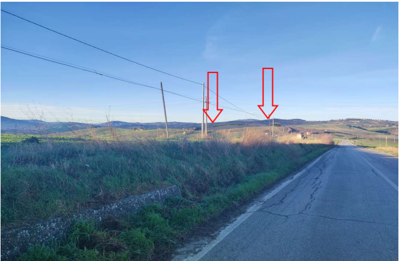
Fig. 90 Punto di presa n. 16 stato di progetto (Strada Statale n°483 ora SP-Termolese)
