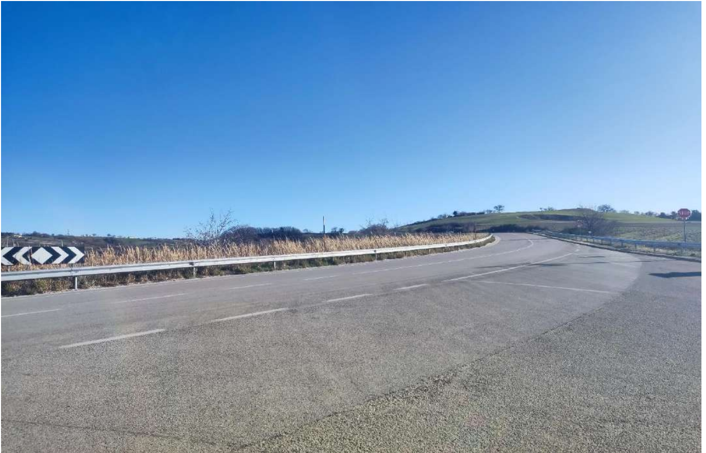
Fig. 3 Punto di presa n. 1 stato di fatto (Tratturo Ateleta Biferno Sant'Andrea)
