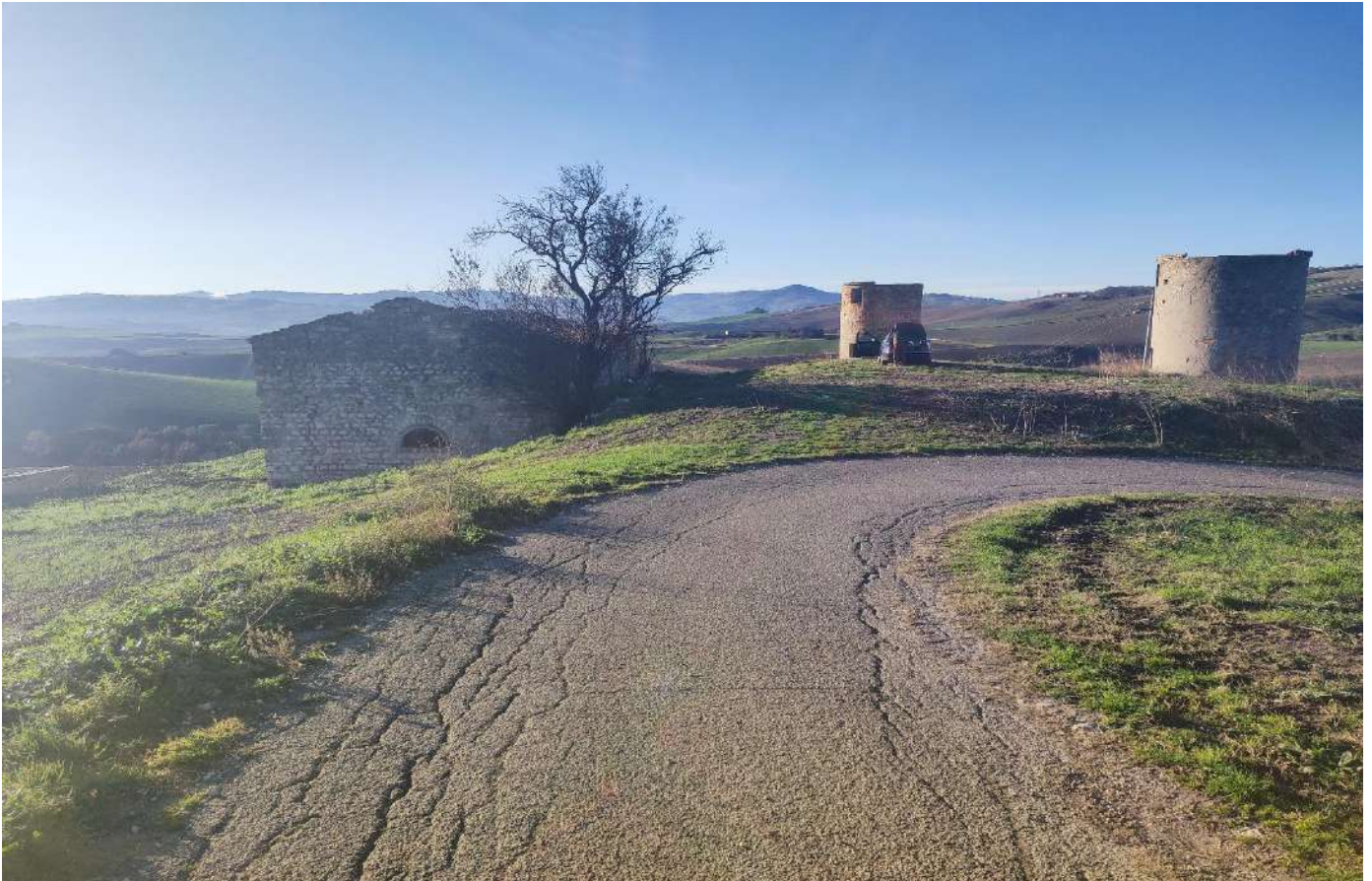
Fig. 63 Punto di presa n. 11.d stato di fatto (Masseria Graziani)
