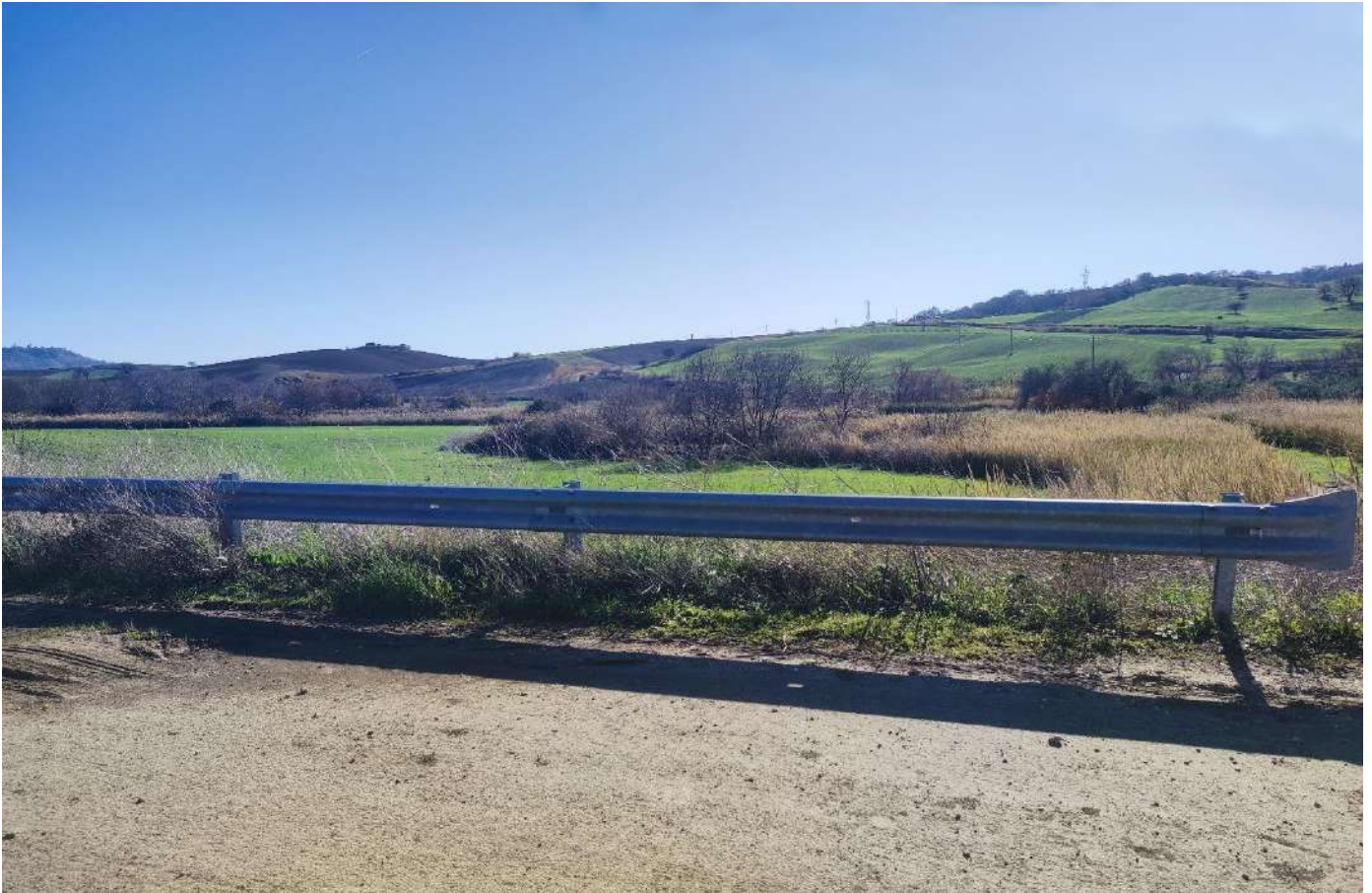
Fig. 117 Punto di presa n. 23 stato di fatto (Tratturo Centurelle - Montesecco)
