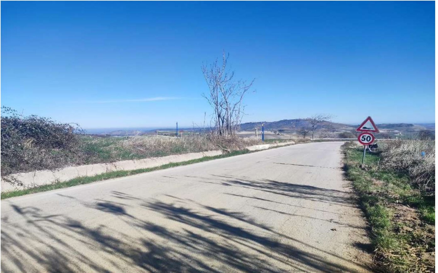
Fig. 19 Punto di presa n. 5 stato di fatto (Strada Statale n°483 ora SP-Termolese)
