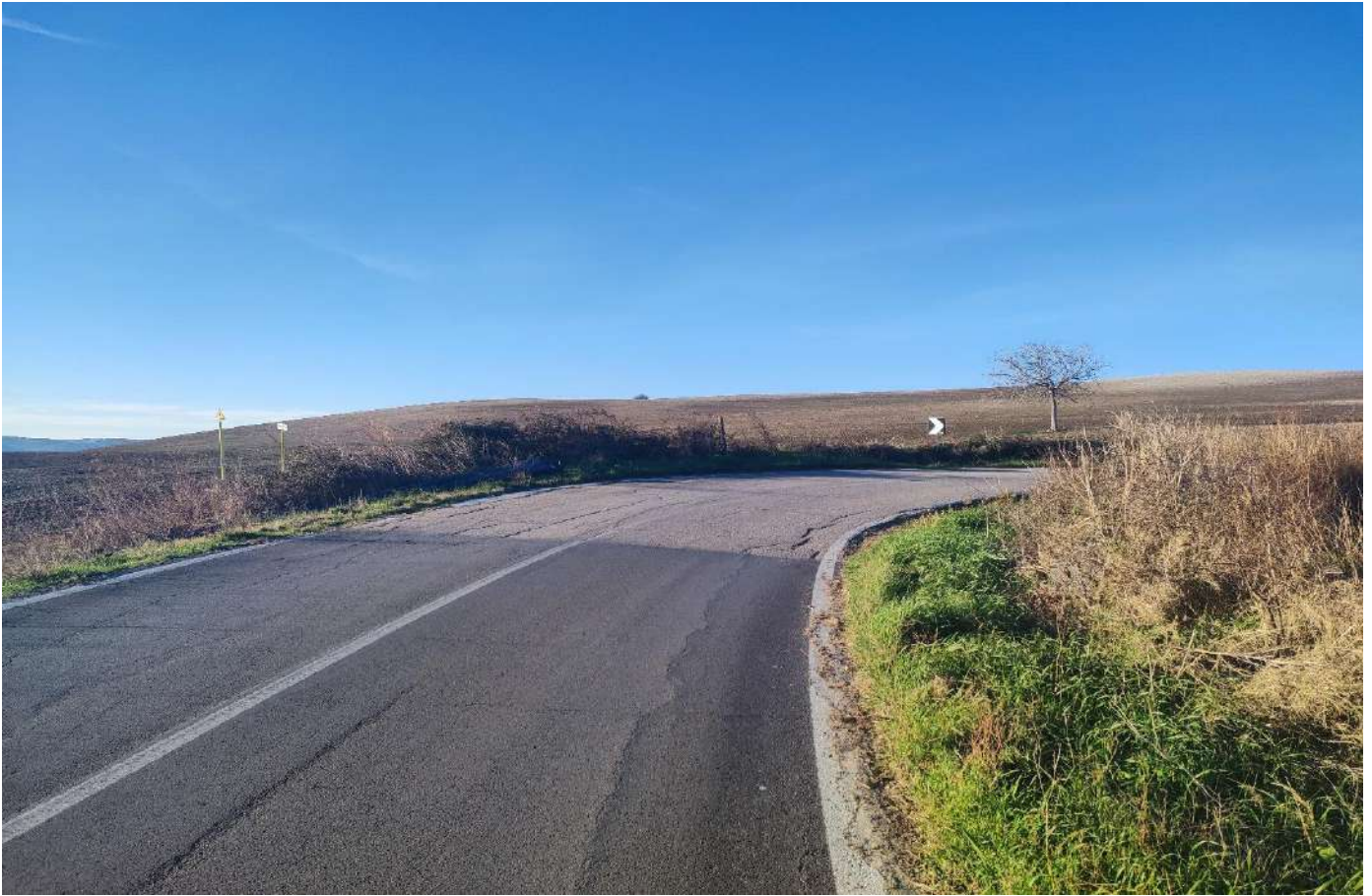
Fig. 39 Punto di presa n. 9.c stato di fatto (Strada Statale n°483 ora SP-Termolese)
