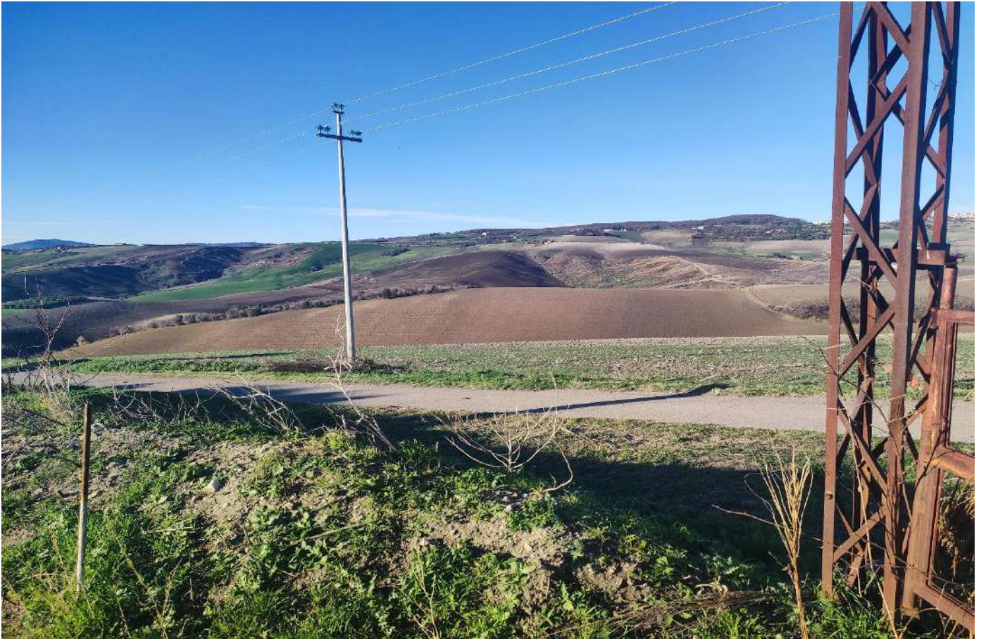
Fig. 51 Punto di presa n. 10.d stato di fatto (Masseria Graziani)
