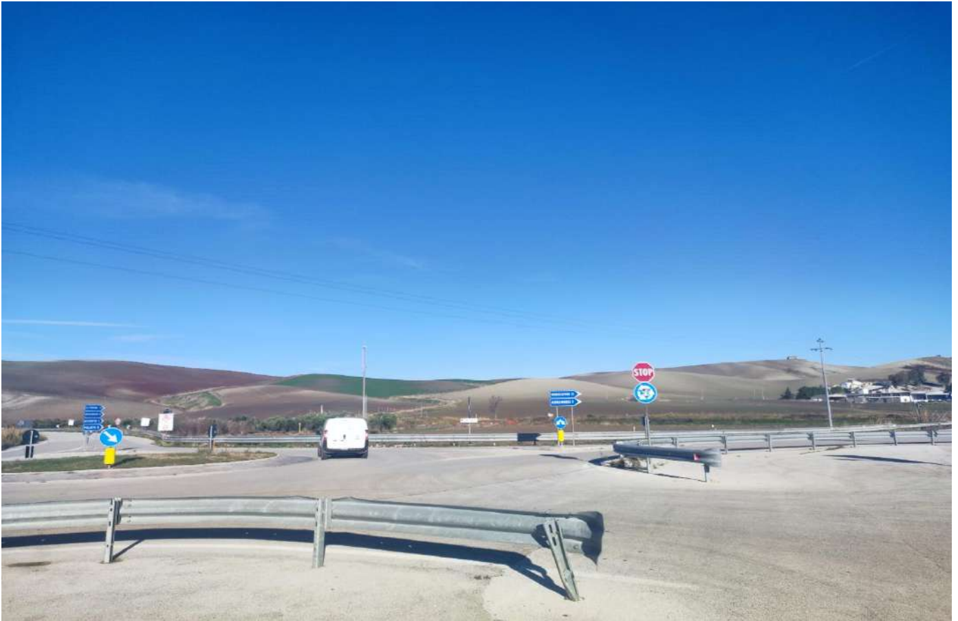
Fig. 77 Punto di presa n. 13 stato di fatto (Tratturo Ateleta Biferno Sant'Andrea)
