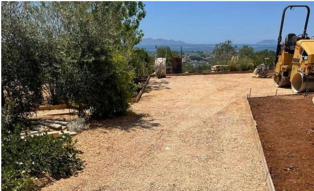
*Figura 6. Realizzazione strada in misto stabilizzato*
