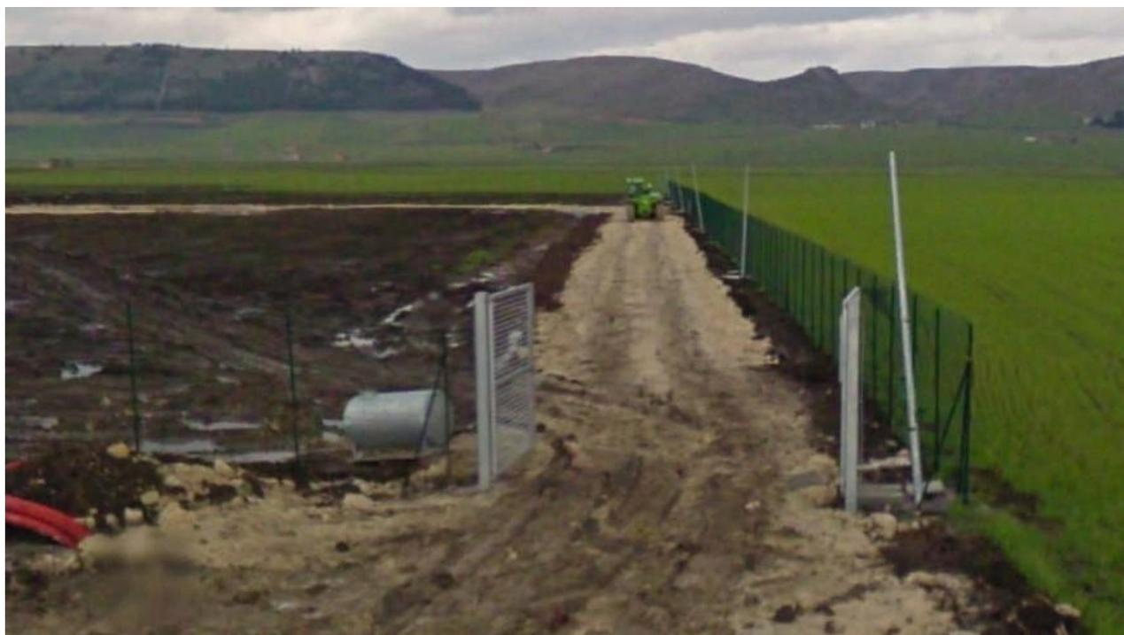
*Figura 7. Fase di cantiere realizzazione viabilità interna d'impianto*
