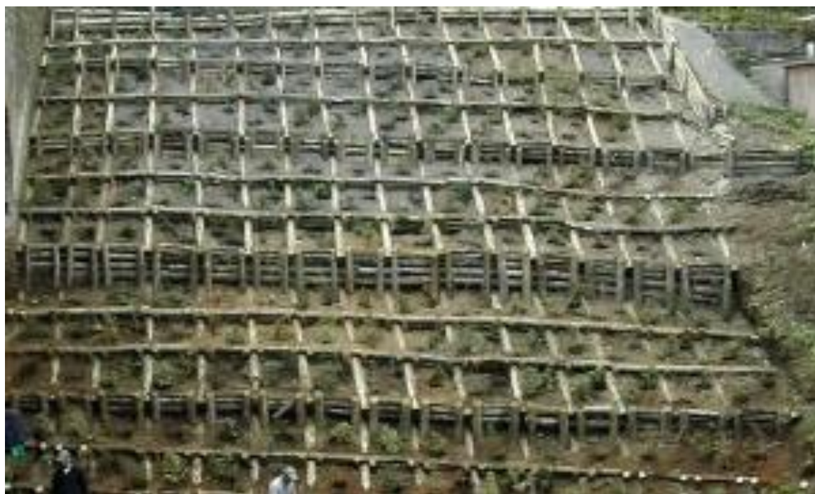
Figura 4. Esempio di graticciata viva
