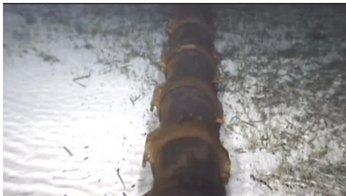
Figura 9 - protezione dei cavi mediante materassi artificiali
