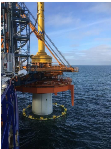
Figura 6 - Palo infisso per battitura
