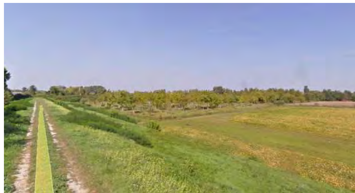
Foto1 - Vista del cantiere 3.AS.13 (google street view)
