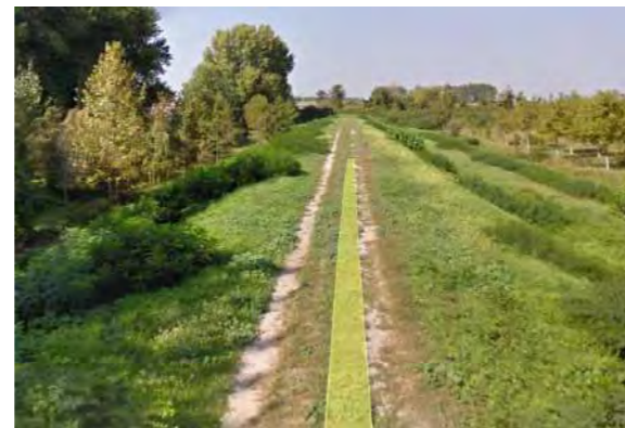
Foto2 - Vista della viabilità arginale in sx idraulica di accesso al cantiere
