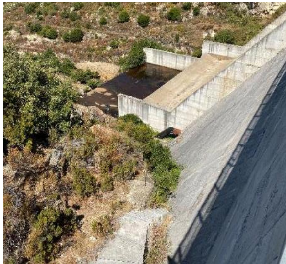
Figura 18 - Viste della scala di accesso in sponda sx non terminata
