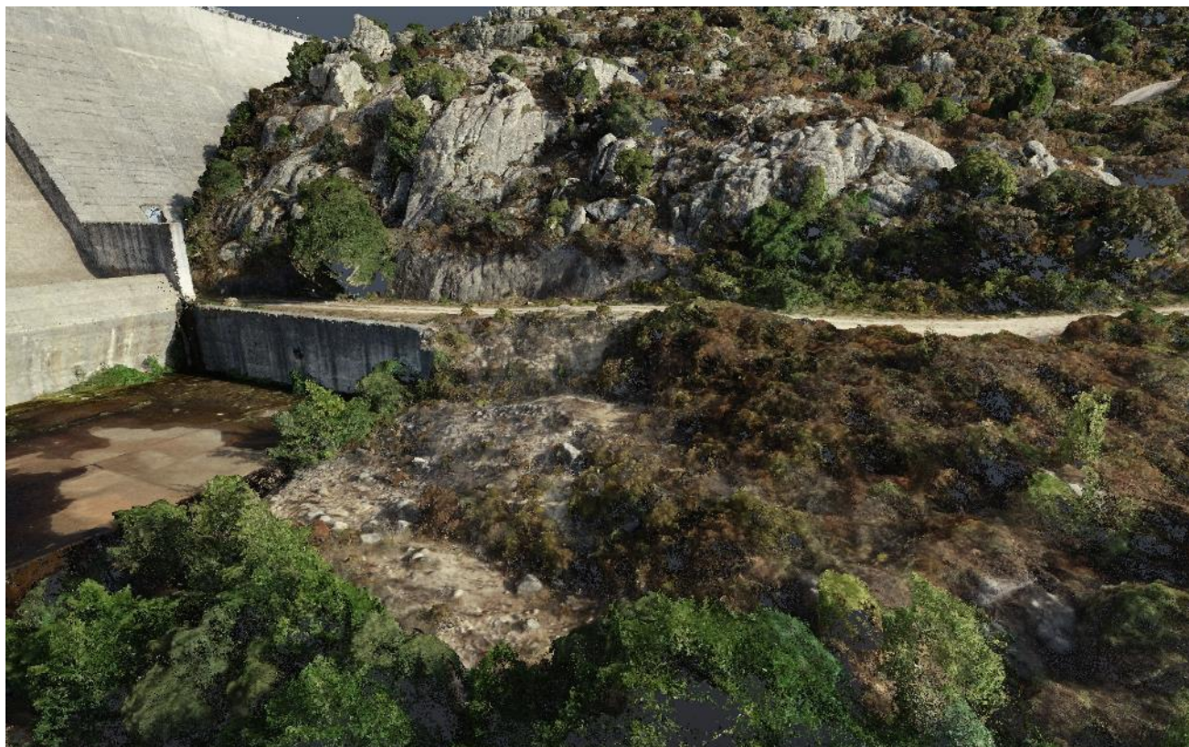
Figura 5 - Estratto nuvola di punti - Erosione della sponda in sx idraulica
