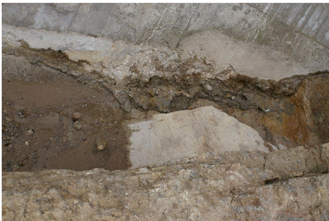
Figura 7 - Vista della zona di contatto roccia-cls portata alla luce prima dell'esecuzione dei carotaggi (anno 2010)
