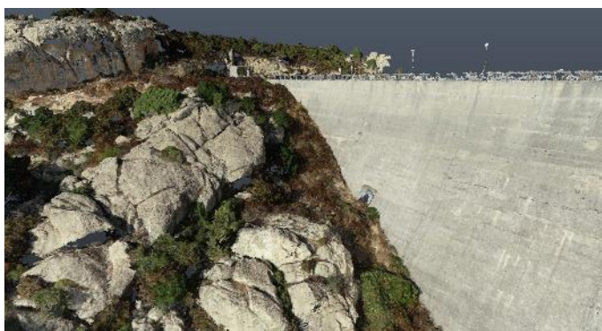
Figura 16 - Estratto dalla nuvola di punti, ingresso al cunicolo sulla sponda nord
