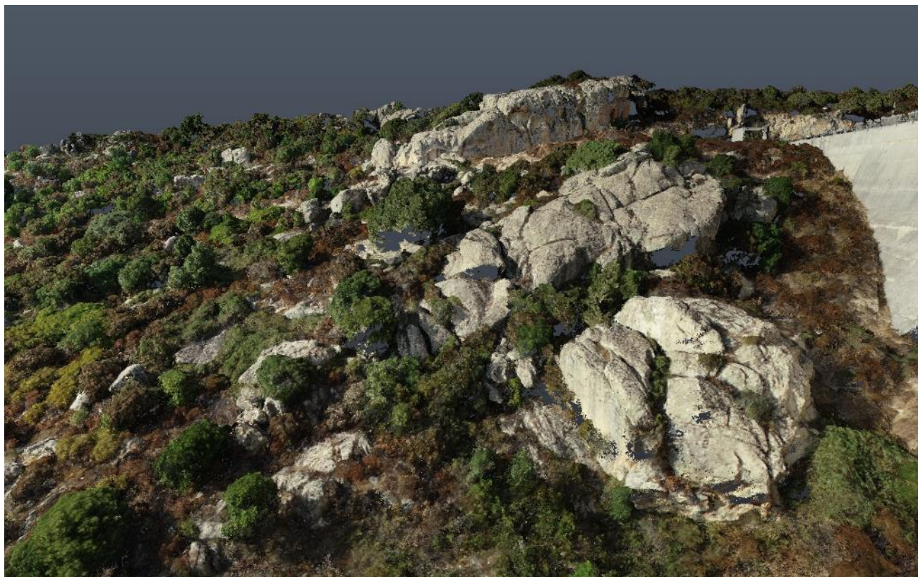
Figura 9 - Estratto nuvola di punti, rilievo del costone soggetto ad instabilità
