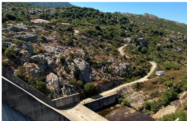
Figura 14 - Viabilità interna, via di accesso al piede del rilevato ed ai cunicoli lato Sud
