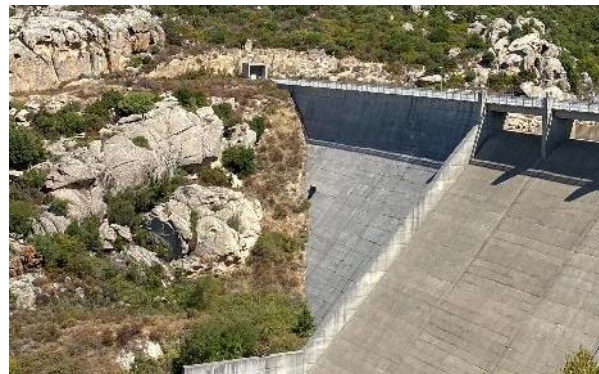
Figura 17 - Vista ingresso cunicolo sponda Nord
