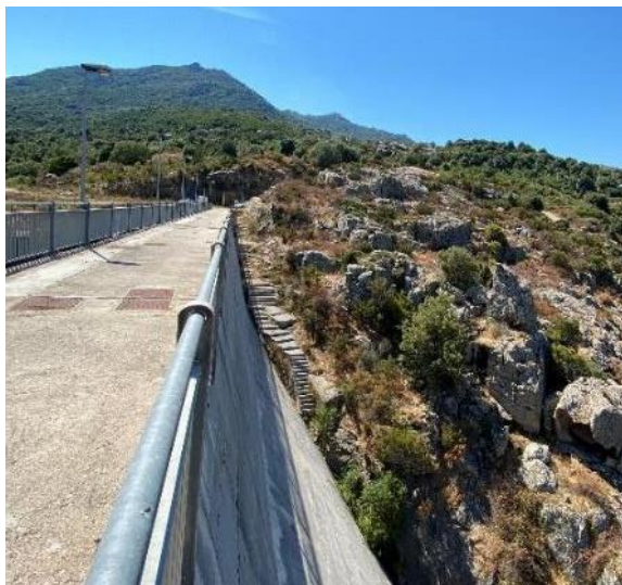
Figura 18 - Viste della scala di accesso in sponda sx non terminata
