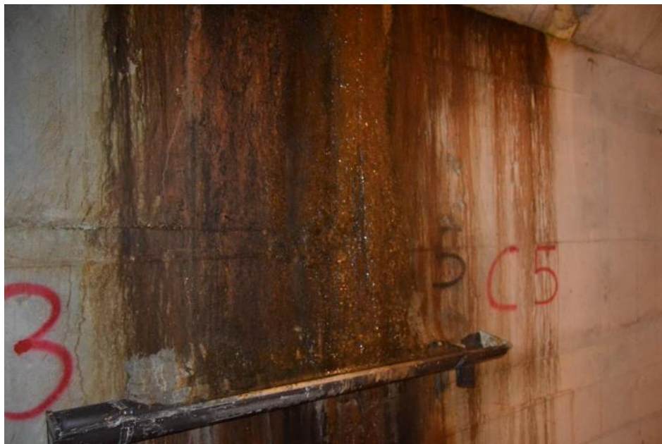
Figura 8 - Vista dall'interno del cunicolo del giunto 3-5
