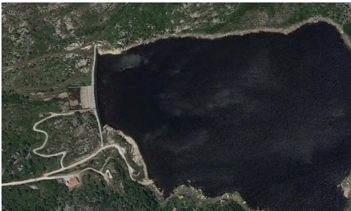
Figura 1 - Diga di Monti di Deu – Vista aerea
