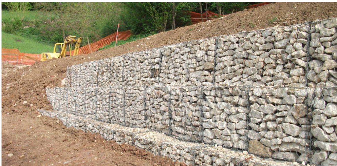
Figura 26 – Esempio di gabbionate metalliche a sostegno del terrapieno
