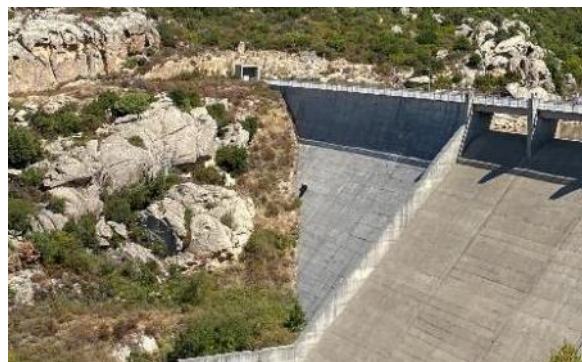
Figura 18 Vista ingresso cunicolo sponda Nord
