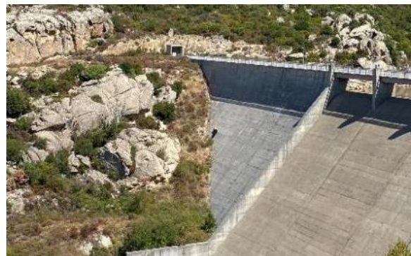
Figura 5-13 Vista ingresso cunicolo sponda Nord
