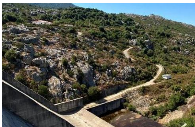
Figura 5-10 Viabilità interna, via di accesso al piede del rilevato ed ai cunicoli lato Sud
