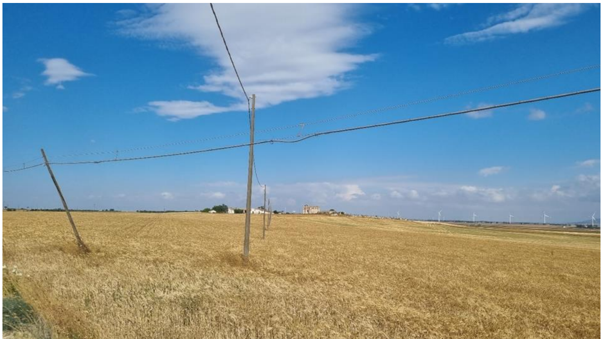
Figura 5.11: Fotoinserimento 4 – Stato di Fatto senza impianto
