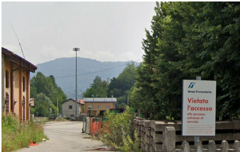
Foto 1 - Vista dell'area da Via Stazione
