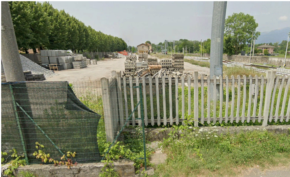
Foto 2 – vista dall'area di accesso al cantiere
