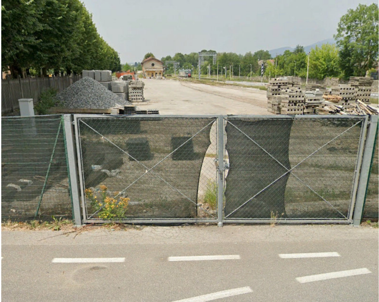
Foto 1 – vista dell'area di cantiere
