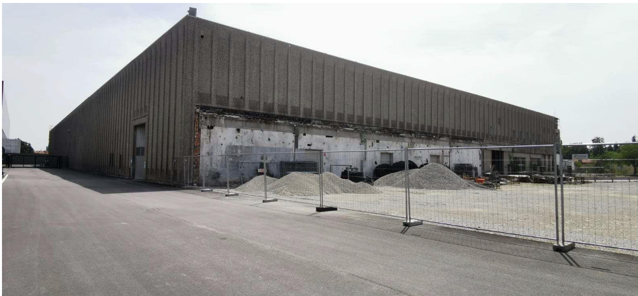
Figura 4: edificio industriale da riconvertire in IT3 DATA CENTER D
