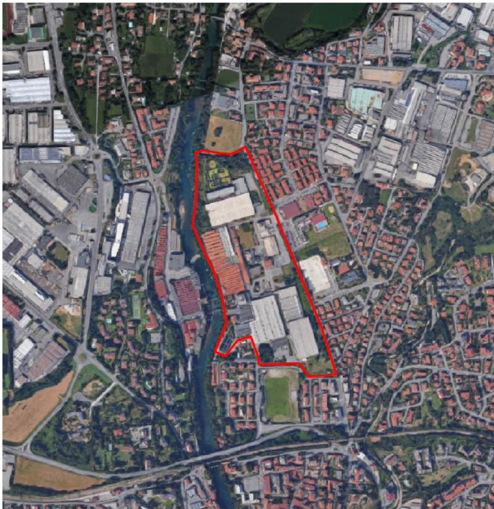
Figura 2 - Ubicazione su ortofoto del Polo Tecnologico Aruba Spa (indicata in rosso)
